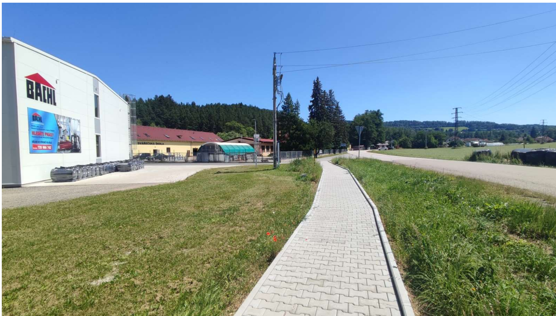
- chodník před areálem firmy BACHL, spol. s r. o.
