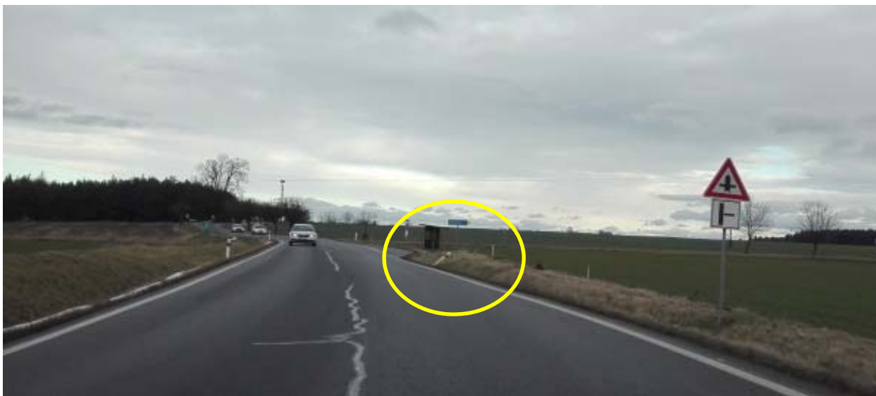
Obrázek 3: Absence středového VDZ. Stav některých směrových sloupků.
