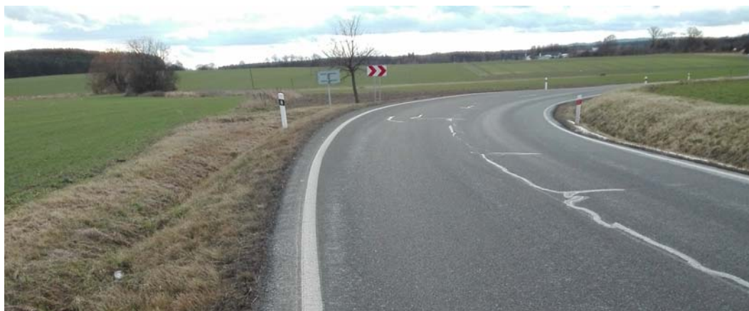
Obrázek 8: Pohled do oblouku po směru staničení.
