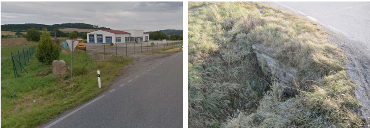
Obrázek 5: Pohled po směru staničení – na fotce vlevo balvany u STK, na fotce vpravo kolmá čela propustku v km 14,58.
