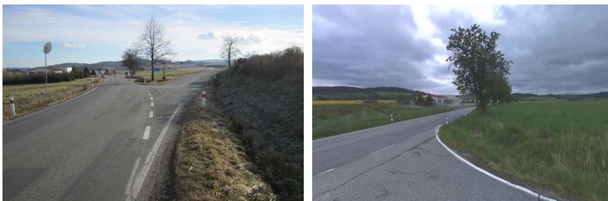
Obrázek 7: Vlevo pohled proti směru staničení na křižovatku z hlavní (patrný nevhodný úhel napojení), vpravo rozhled vpravo z druhé větve vedlejšího paprsku.
