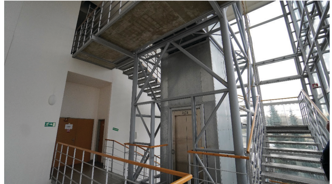
Prosklené schodiště s výtahem
