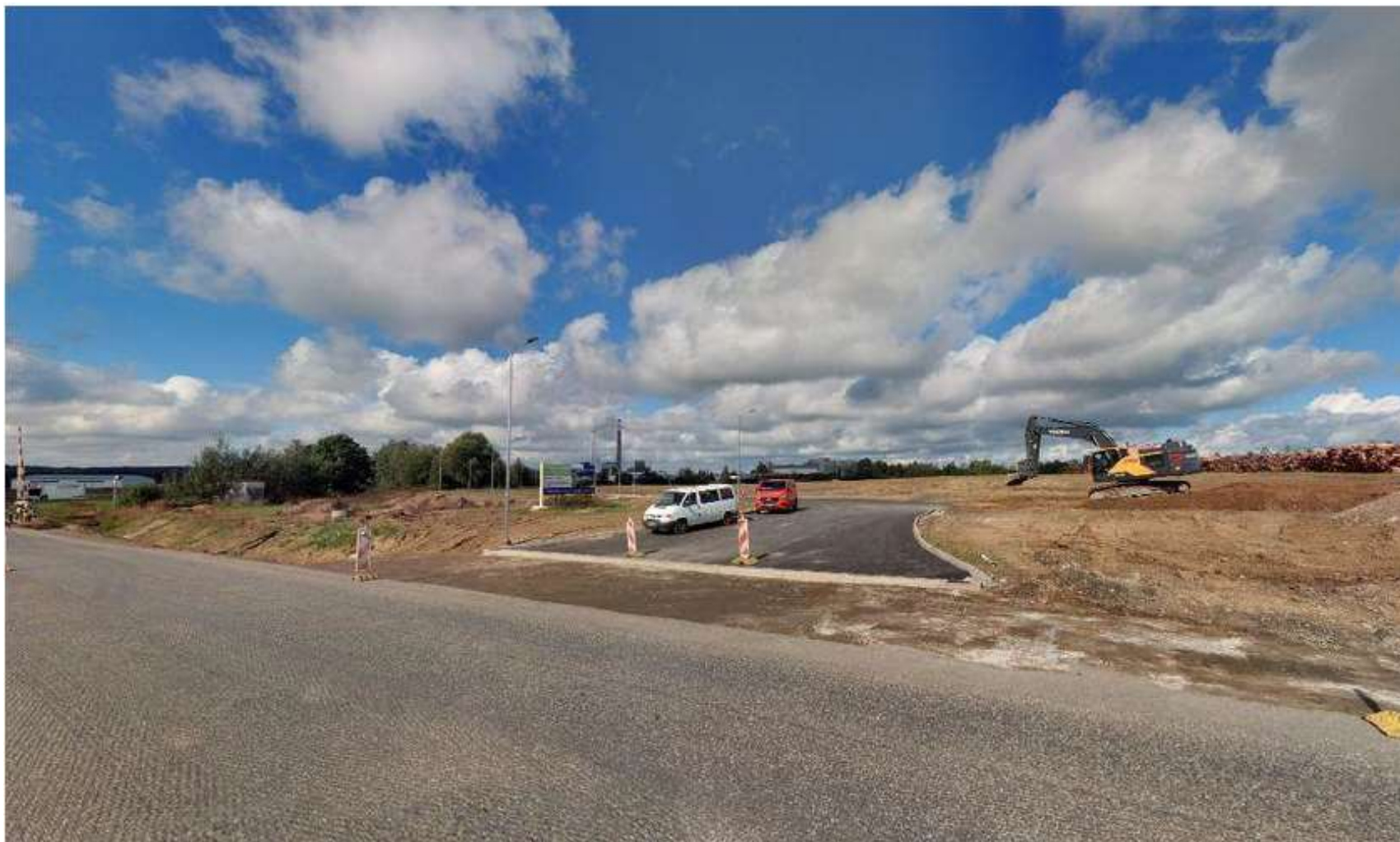
p. č. 1641/73 a č. 1641/75 – sjezd na příjezdovou komunikaci do průmyslové zóny
