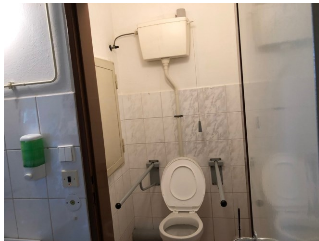
Obr. 6 – pavilon C (LDN) – WC
