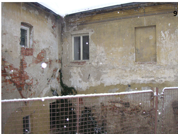
Snímek č. 9 - detail stavu zdiva a omítek; č. 10 - pohled na vstupní bránu od muzea z Lidické ulice, vpravo předmětný objekt, v pozadí kostelní věž
