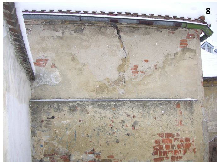
Snímek č. 7 - vlevo předmětný objekt, vpravo průchod od muzea k hlavní budově Školy; č. 8 - detail pukliny ve zdi předmětného objektu za průchodem
