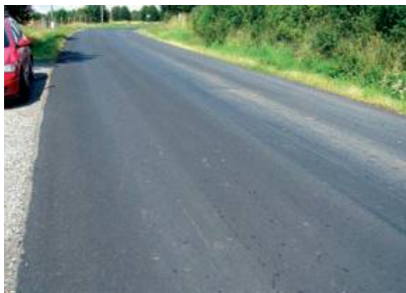
Část opravené silnice II/120 hranice okresu Benešov – Mladá Vožice.
