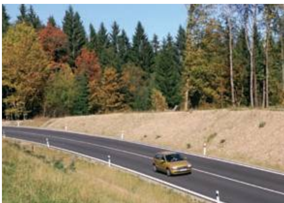
Přeložka silnice II/163 u Vyššího Brodu odstranila nebezpečné místo na komunikaci, kde v minulosti došlo k řadě dopravních nehod.
