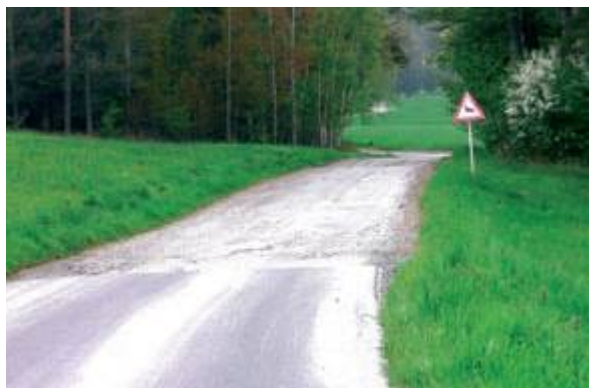
Díky prostředkům z Grantového programu na Rozvoj infrastruktury podporující šetrnou turistiku obnovilo město Trhové Sviny povrch cyklotrasy Nežetice-Todeň.
