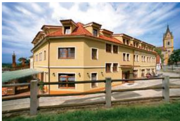
V rámci grantového schématu Společného regionálního operačního programu pro cestovní ruch v Jihočeském kraji pro podnikatelské subjekty se realizovala rekonstrukce Hotelu Závěš z Falkenštejna v Hluboké nad Vltavou.
