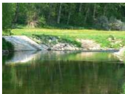
LO 1 – Img Dolní Ostrovec
