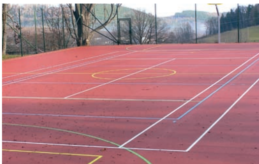
V rámci grantového programu Jihočeského kraje „Rekonstrukce a obnova vybavení stávajících sportovišť“ se realizovala oprava víceúčelového hřiště ve Vacově.
