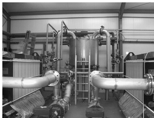
obr. 53 - Aktivační čistírna pro čištění průmyslových odpadních vod s následnou separací biomasy membránovou filtrací
