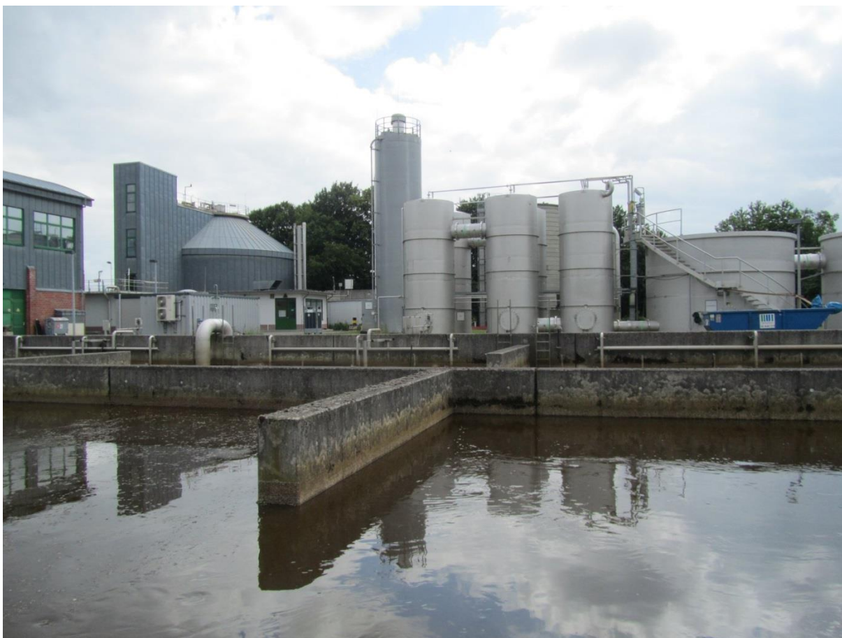
obr. 59 - Ozonizační stupeň na ČOV Schwerte
