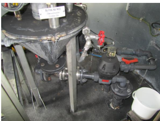
obr. 60 - Dávkování práškového aktivního uhlí a sorpční nádrže
