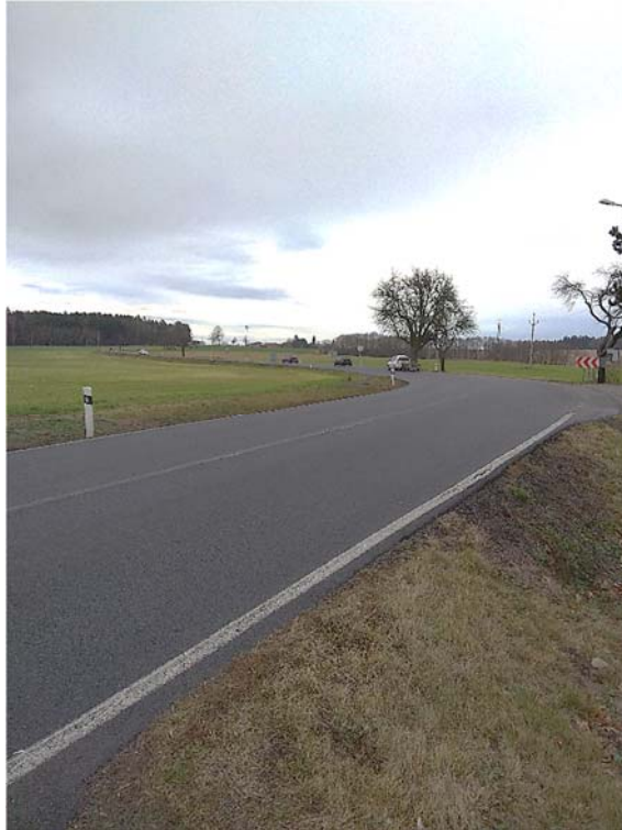
Obrázek 11: Absence nezpevněné krajnice.
