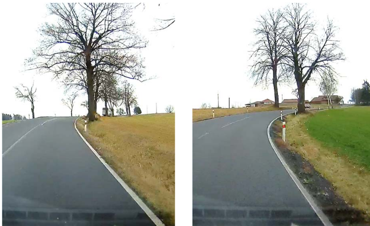
Obrázek 5: Zeleň omezující rozhled pro zastavení.
