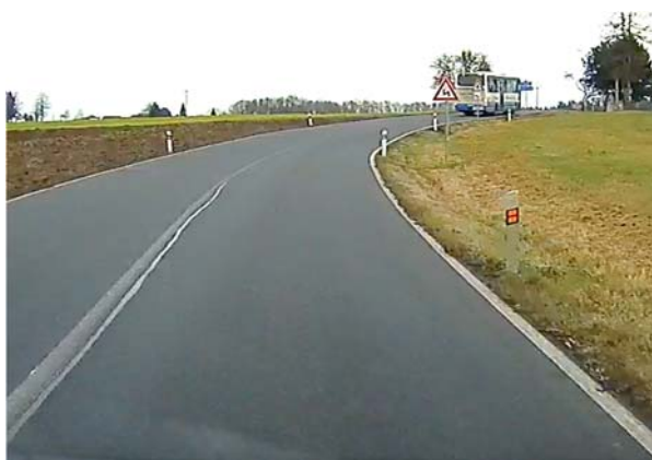
Obrázek 7: Směrové oblouky v km 16,35, pohled ve směru na Otěvěk.
