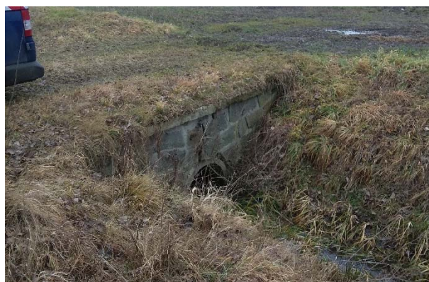
Obrázek 4: Zleva doprava a dolů – km 5,07 betonová skruž vlevo, km 5,45 betonová skruž vpravo, km 5,40 rozvodná skříň vlevo, km 5,44 kolmé čelo propustku na kanále.
