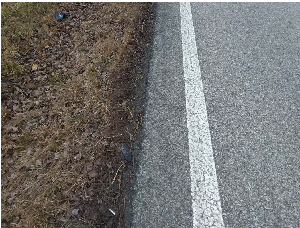
Obrázek 5: Pohled na hranu zpevnění – nezpevněná krajnice je pojížděna i v přímé, což ukazuje na nedostatečnou šířku zpevnění.
