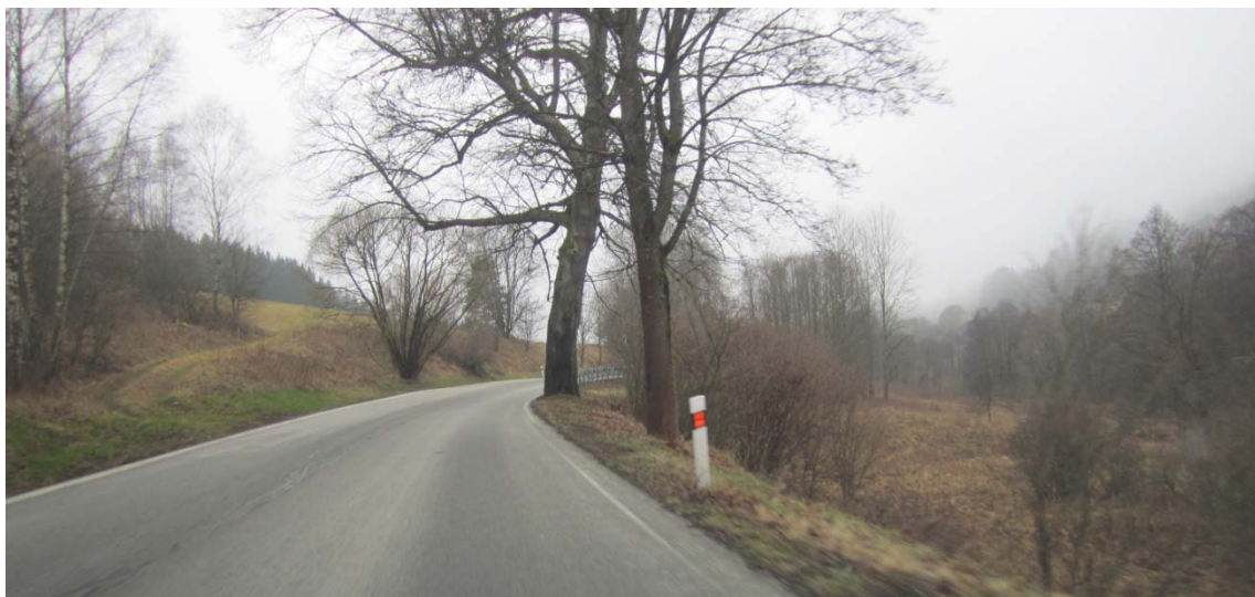
Obrázek 7: Pohled na nedostatečnou délku svodidla
