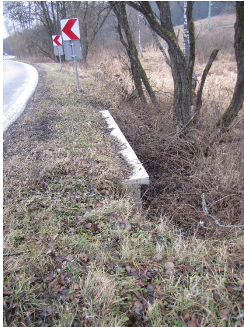
Obrázek 9: Pohled na čelo propustku vlevo ve směru na Dolní Dvořiště.
