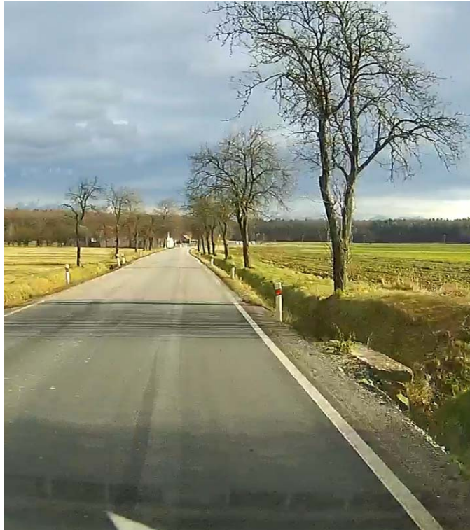
Obrázek 5: Pohled na bok čela propustku ve směru na České Budějovice.
