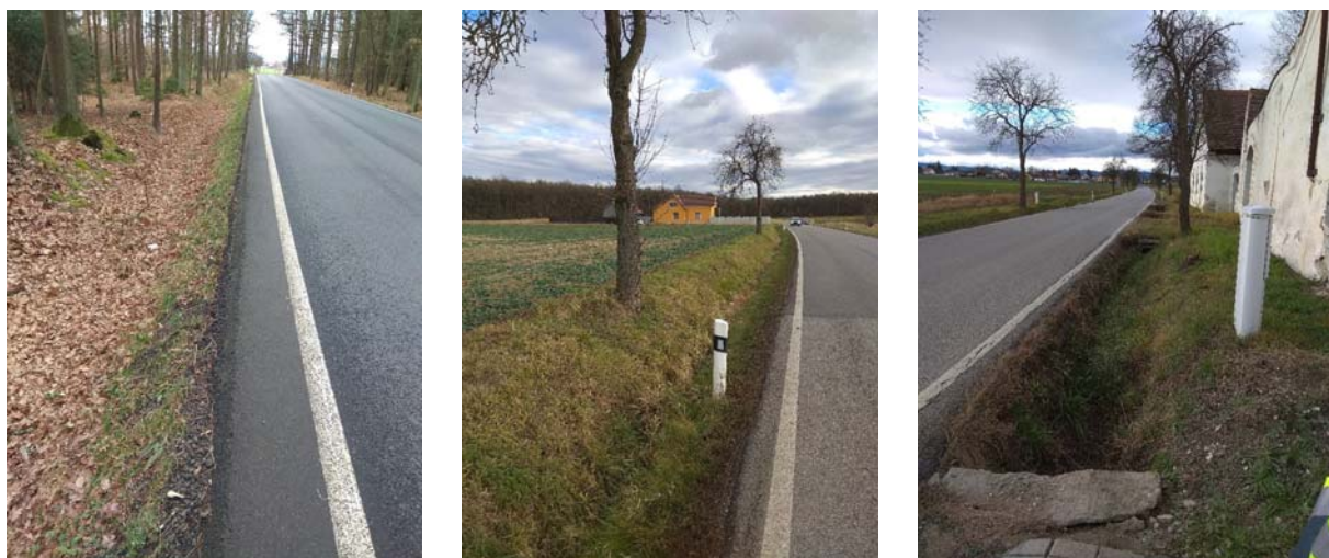
Obrázek 7: Příklady chybějících nezpevněných krajnic.
