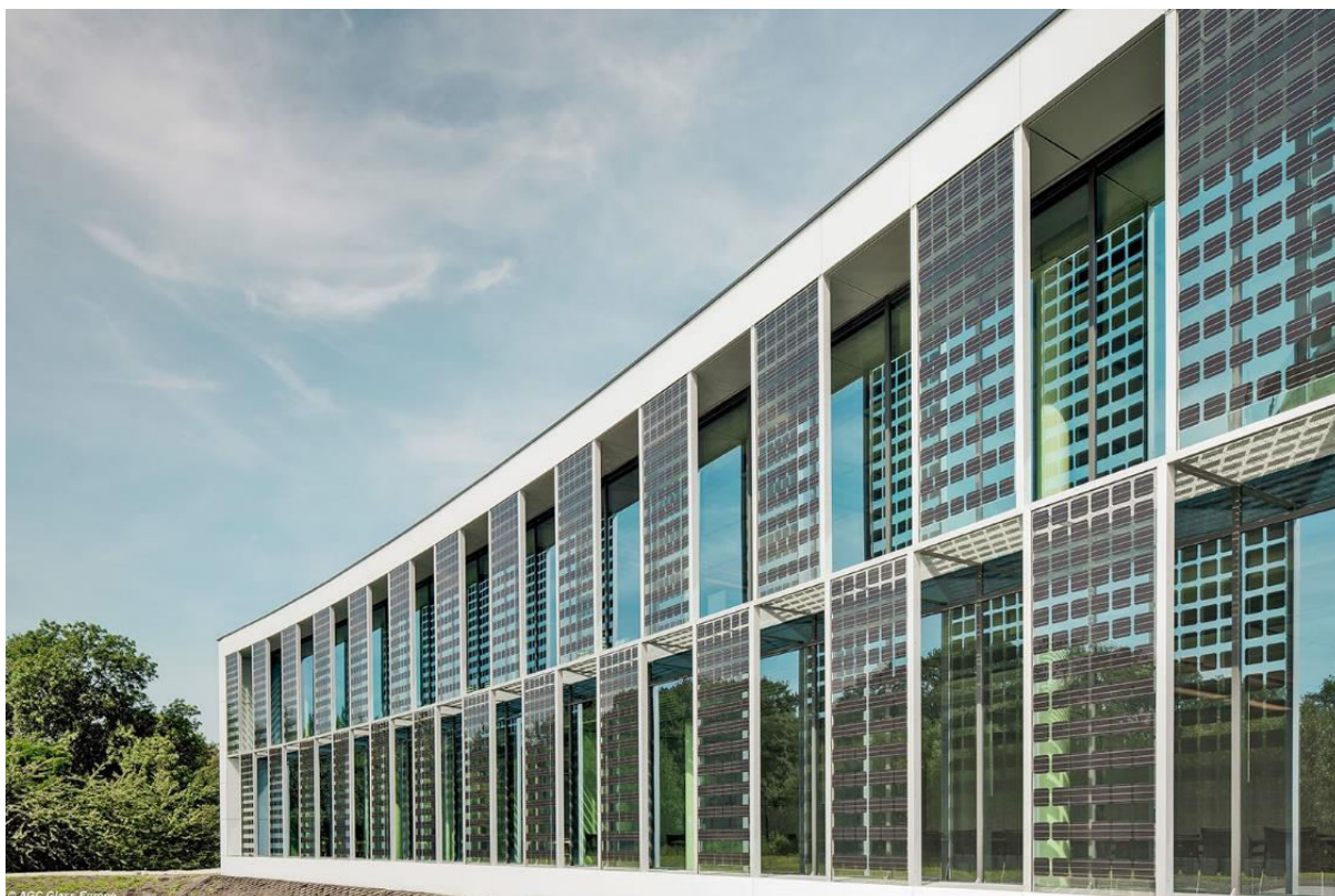
AGC Technovation Centre, Belgie – semi-transparentní a transparentní FV moduly Novostavby a stavebně integrované FVS – fasádní plášť Zdroj: https://www.stavbaweb.cz/agc-technovation-centre-12581/clanek.html
