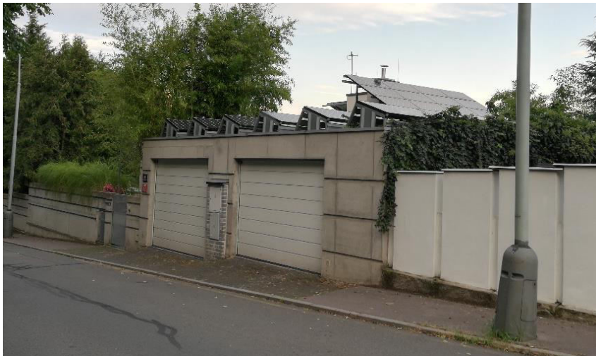
Praha, negativní příklad instalace FVS na ploché střeše, FVS panely na nakloněné konstrukci nezanedbatelně přesahují výšky atiky a tím se pohledově uplatňují v blízkých i dálkových pohledech.
