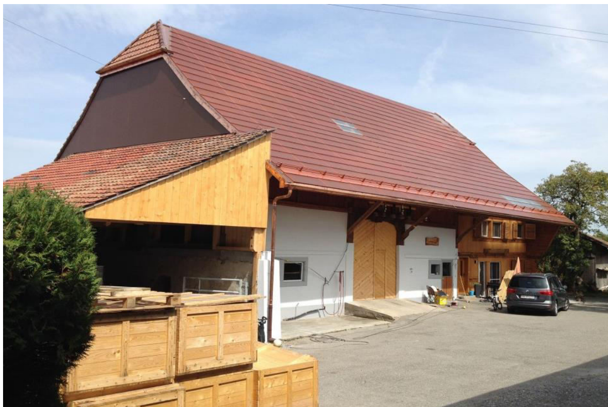
Vesnice Ecuwillens, venkovská farma, fotovoltaické tašky vzhledu pálené střešní krytiny Zdroj: http://www.issol.eu/world-first-photovoltaic-solar-panels-installed-protected-sites/
