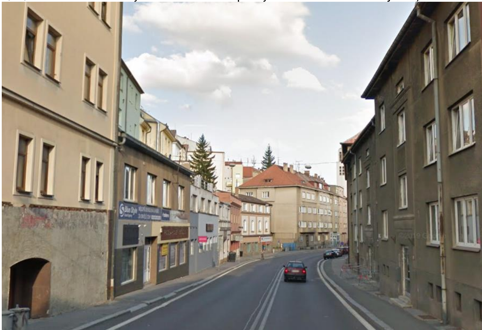
Obr. 10: Fotodokumentace zástavby v okolí kritického místa priority I ve městě Tábor - ulice Budějovická, komunikace II/137
