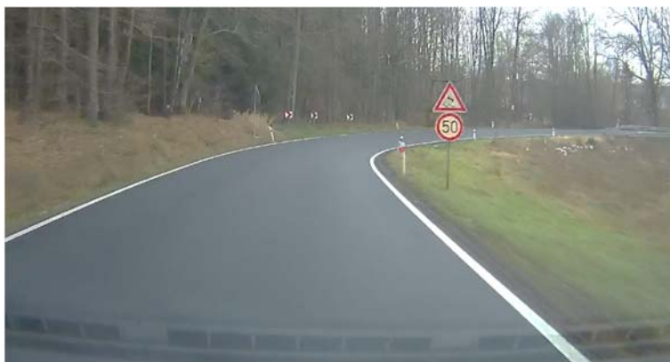
Obrázek 8: Směrový oblouk v km 38,17 – pohled ve směru na Borovany (ve směru staničení).
