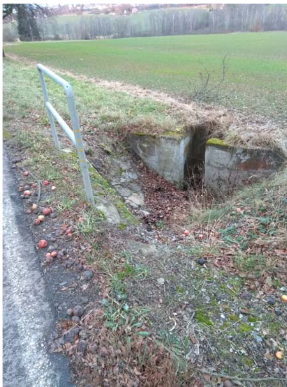
Obrázek 4: Horská vpust – pohled na ve směru na Borovany (ve směru staničení).
