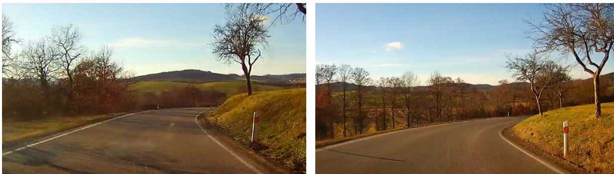
Obrázek 7: Rozhledy na zastavení v pravostranných obloucích v km 25,18 a v km 25,36 jsou zkráceny přilehlým svahem.
