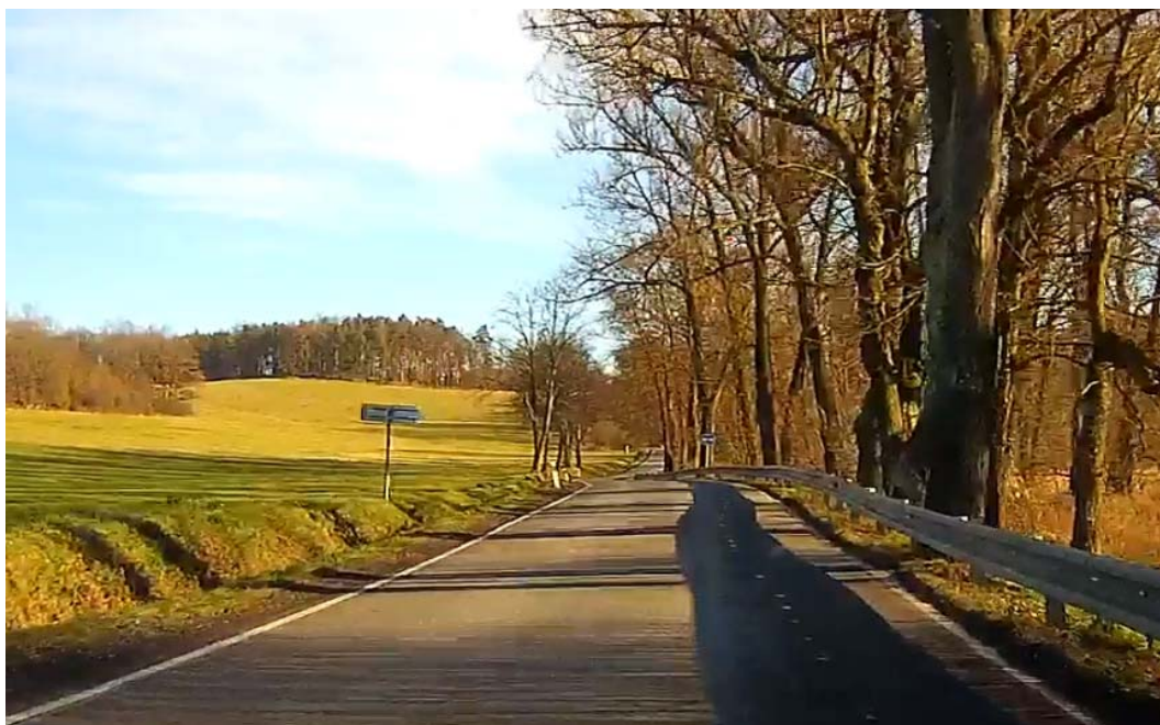
Obrázek 10: Stromy za svodidlem jsou v deformační zóně záchytného zařízení (pohled na úsek proti směru staničení).
