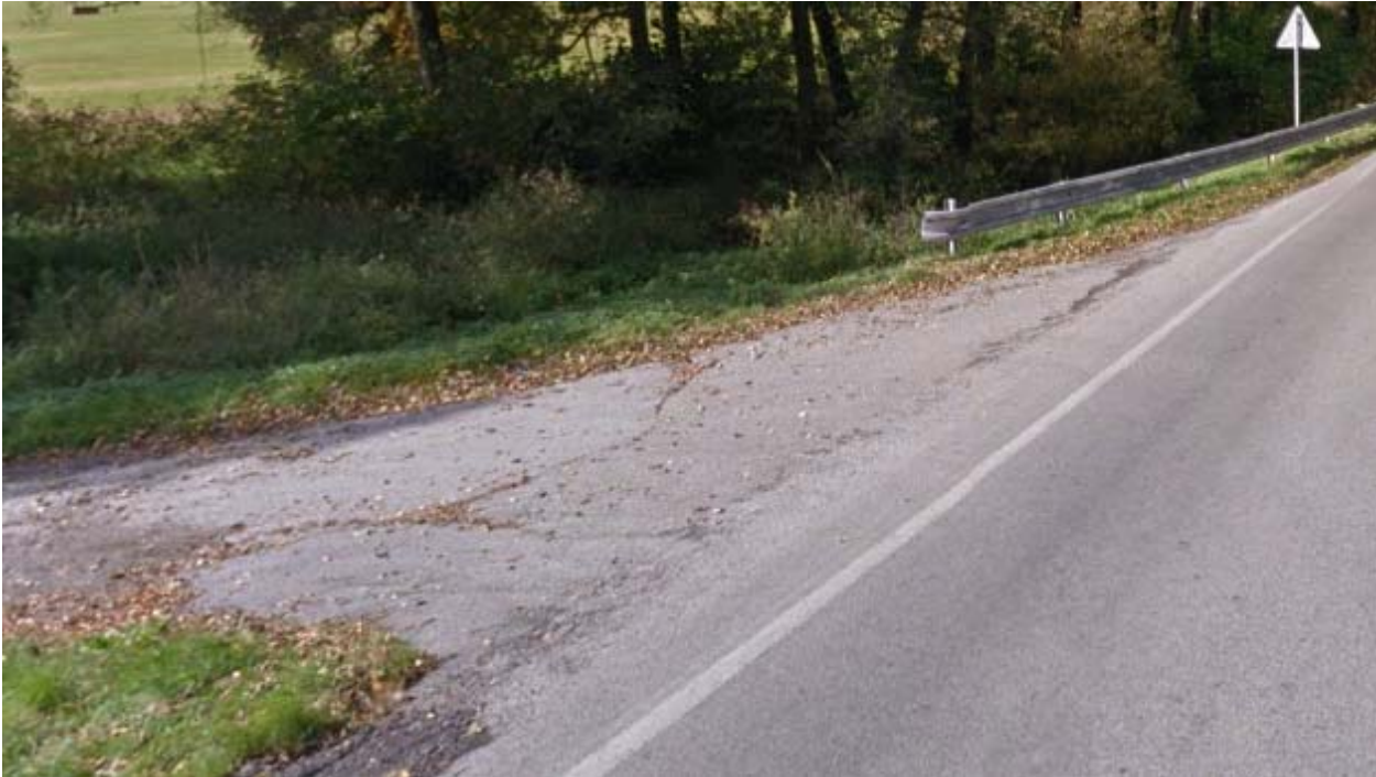
Obrázek 11: Pohled po směru staničení na ukončení svodidla vlevo
