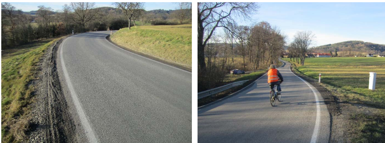
Obrázek 5: Oblouk v km 25,36 (vlevo) a v km 25,47 (vpravo) pohled po směru staničení.
