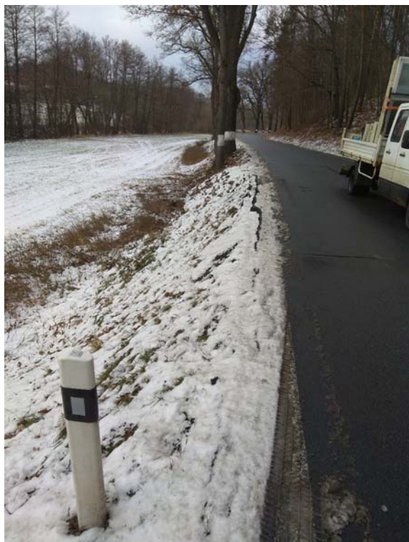
Obrázek 13: Chybějící nezpevněná krajnice vpravo, ukázka.
