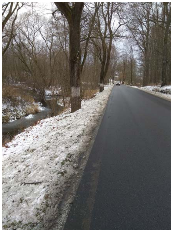
Obrázek 5: Souběh silnice a vodního toku, km cca 15,46.
