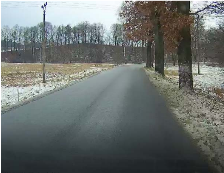
Obrázek 4: Nájezd do směrového oblouku od obce Křenov (ve směru staničení).
