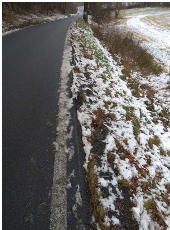
Obrázek 13: Chybějící nezpevněná krajnice vpravo, ukázka.
