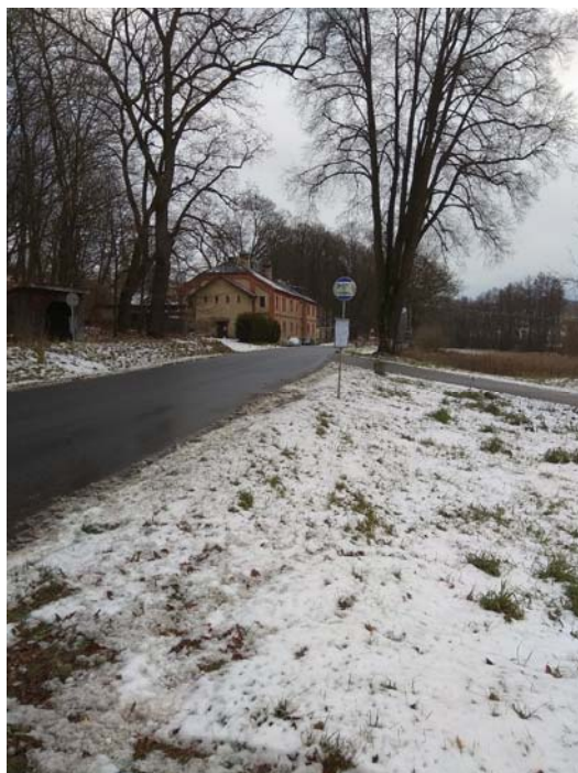
Obrázek 6: Omezení rozhledu označником zastávky na vidlicové křižovatce.
