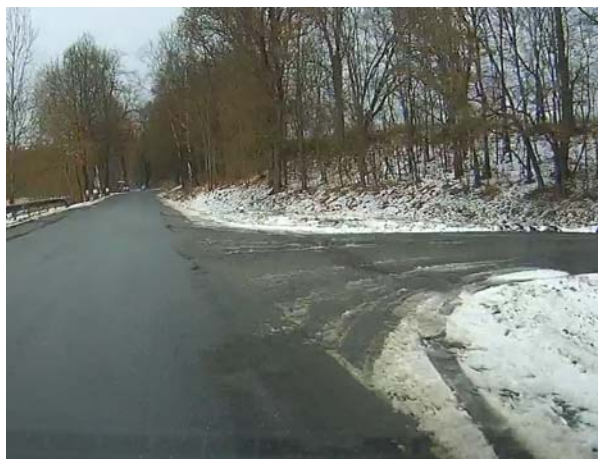
Obrázek 11: Pohled na připojení silnice III/1599 na sil. II/166 ve směru na Křenov (proti směru staničení)
