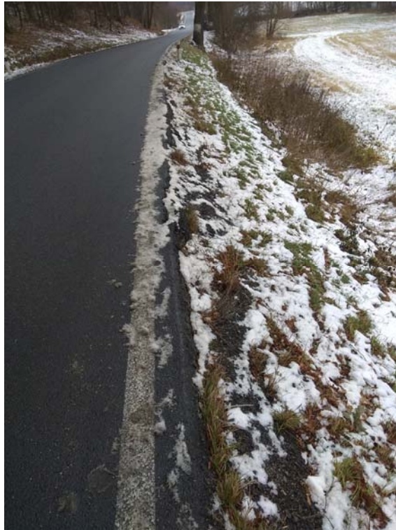
Obrázek 9: Svah vpravo (pohled po směru staničení).
