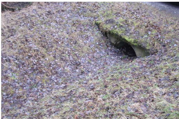
Obrázek 3: Ukázka míst s nedostatečným odvodněním.
