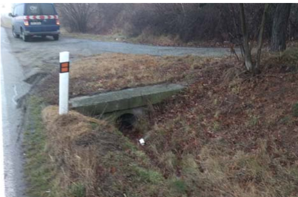
Obrázek 7: Kolmá čela propustků km 4,58 vlevo a km 4,61 vpravo
