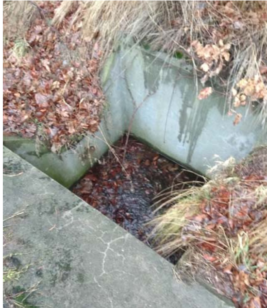
Obrázek 6: HV v km 4,41.
