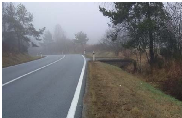
Obrázek 7: Kolmá čela propustků km 4,58 vlevo a km 4,61 vpravo
