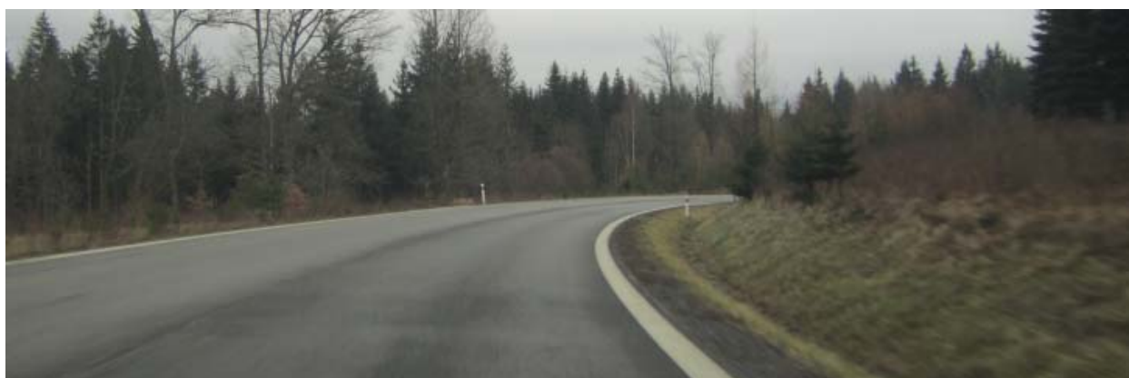
Obrázek 8: Směrové oblouky s nedostatečnými rozhledovými poměry.
