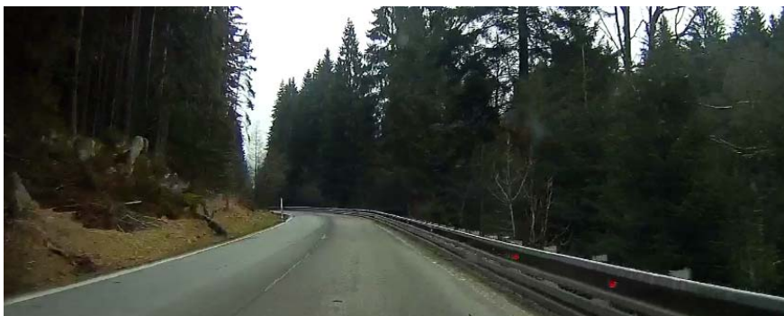
Obrázek 10: Směrový oblouk s nedostatečnými rozhledovými poměry.
