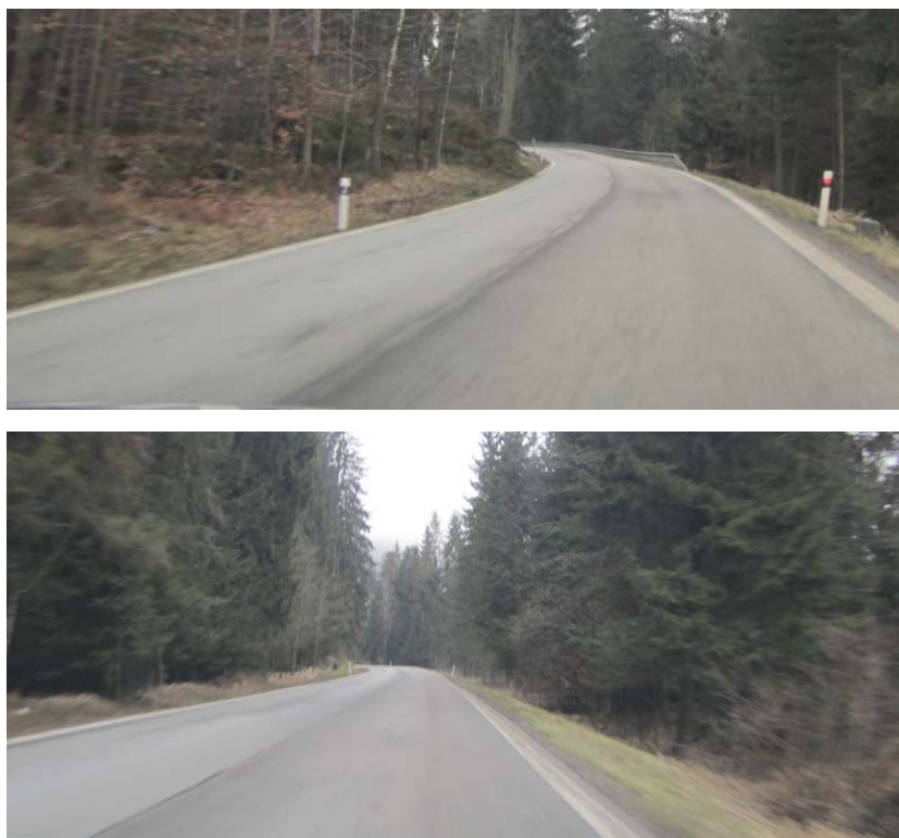
Obrázek 4: Ukázka nezpevněných krajnic.
