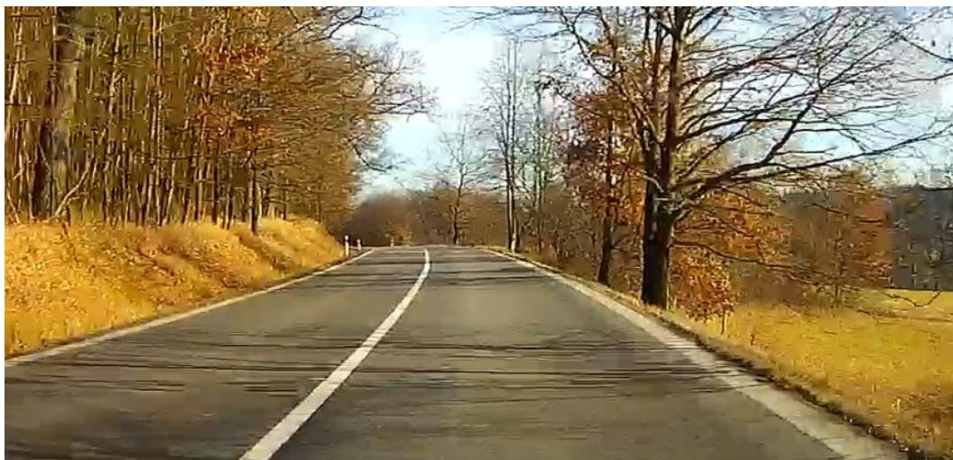
Obrázek 6: Pohled do oblouku po směru staničení.
