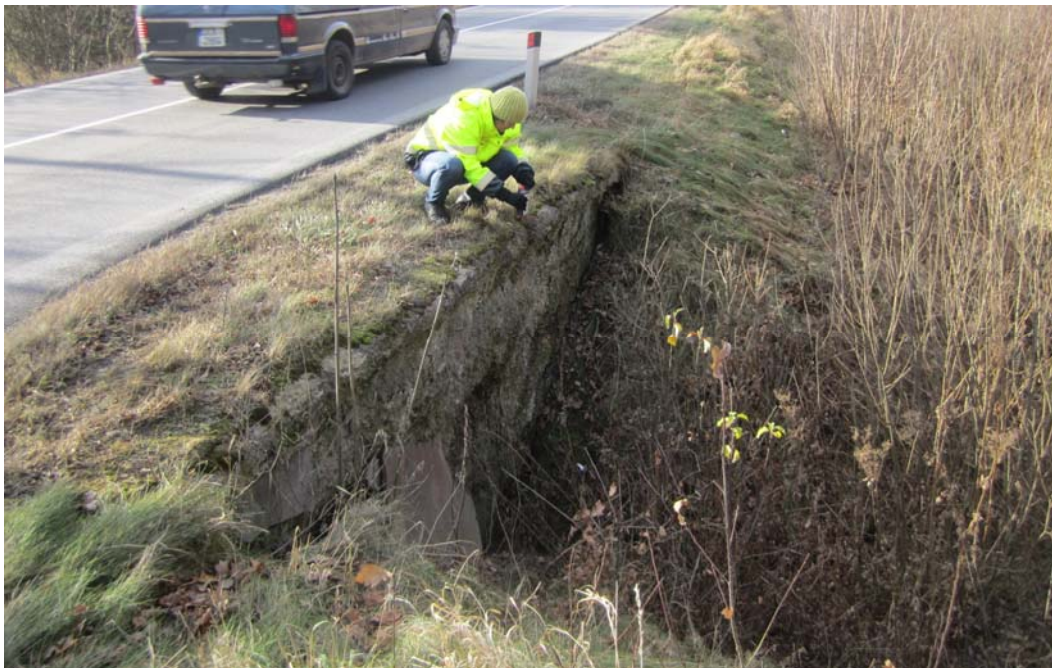
Obrázek 4: Pohled proti směru staničení na výtok propustku v km 71,48.
