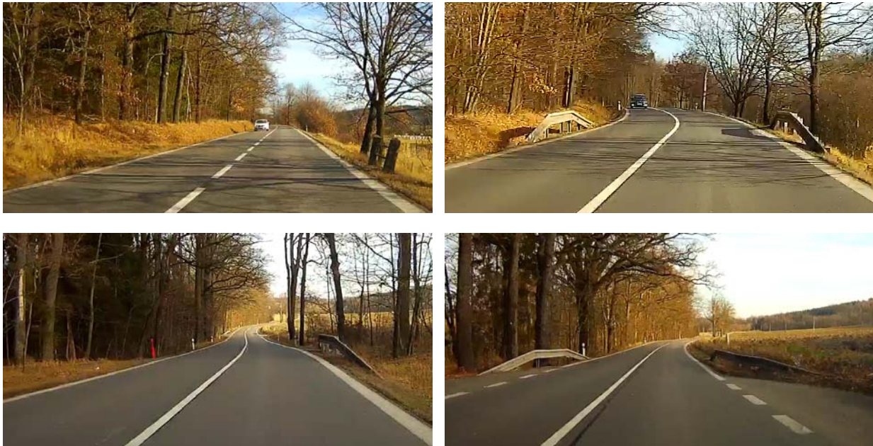
Obrázek 5: Pohled na svodidla po směru staničení v pořadí dle staničení.
