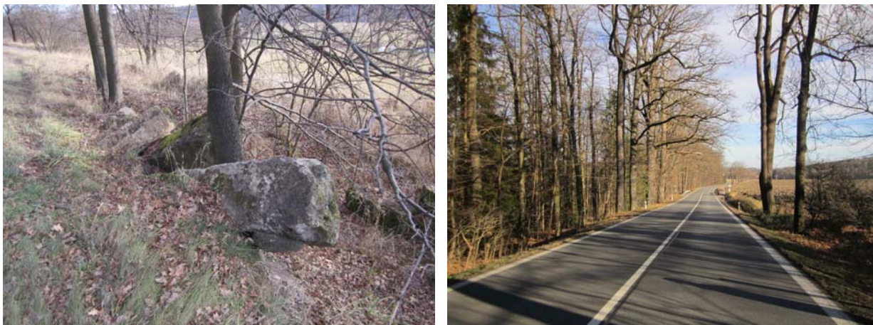
Obrázek 7: Vlevo pohled na bloky po pravé straně zpevnění v km 72,48, vpravo stromy tvořící pevnou překážku v km 72,97.
