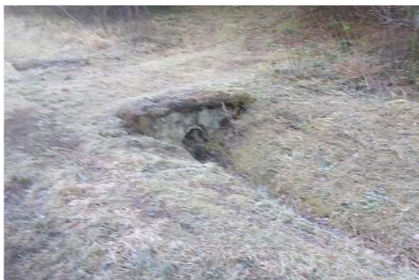
Obrázek 4: Pohled na pevné překážky (vlevo a vpravo proti směru staničením dole propustek po směru staničení).
