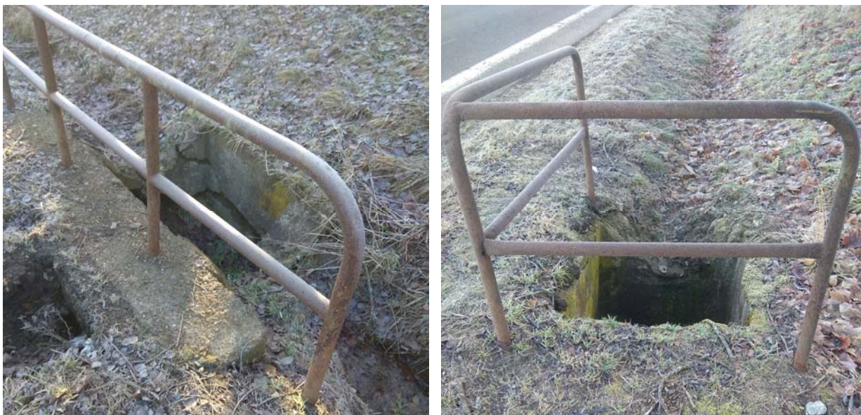
Obrázek 5: Pohled na HV (vlevo km 45,78, vpravo km 46,14).
