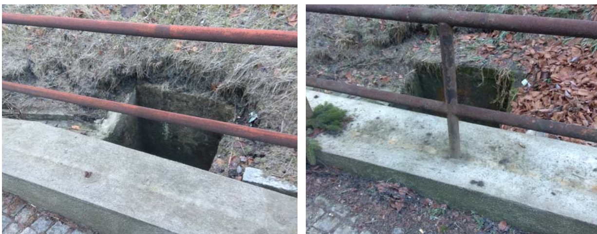
Obrázek 6: Pohled na HV (vlevo km 46,62, vpravo km 46,92).
