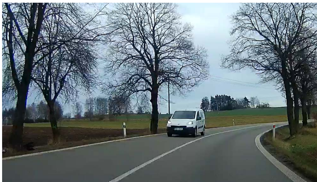
Obrázek 8: Pohled po směru staničení stromy blízko hrany zpevnění
