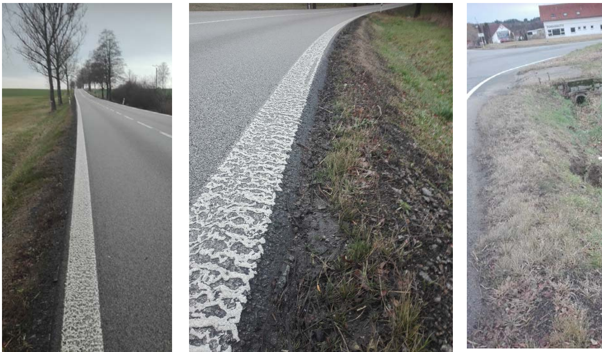
Obrázek 6: Příklady nevhodné krajnice (vlevo a uprostřed malá šířka krajnice, vpravo nadvýšená krajnice).
