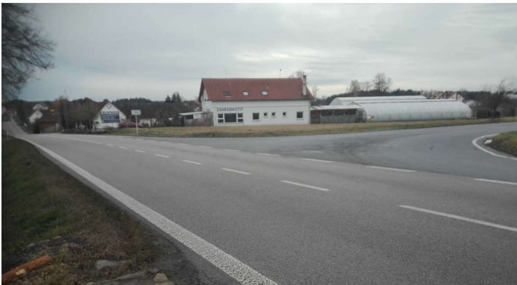
Obrázek 5: Pohled na plochu křižovatky proti směru staničení.
