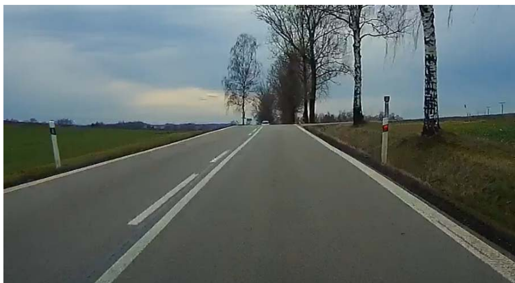
Obrázek 10: Pohled na výškový oblouk v místě křižovatky proti směru staničení
