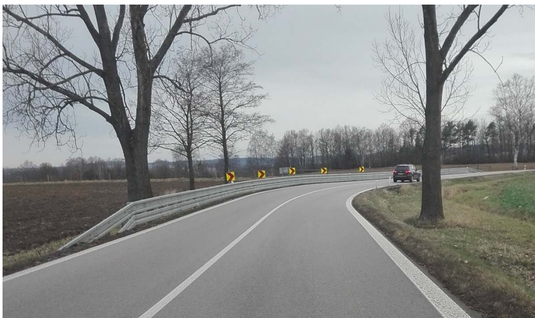
Obrázek 9: Pohled do oblouku proti směru staničení (ve směru všech nehod)
