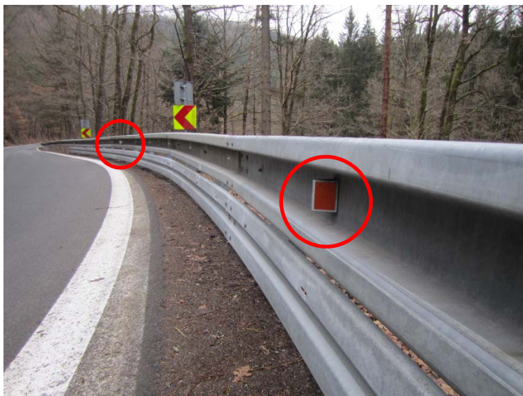
Obrázek 11: Nedostatky ve vedení komunikace.
