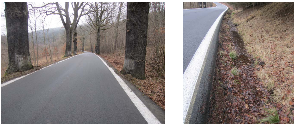
Obrázek 4: Příklad chybějící krajnice na úseku
