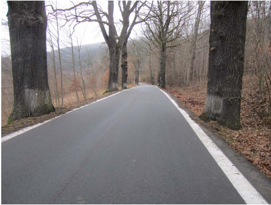
Obrázek 8: Ukázka průjezdné šířky komunikace
