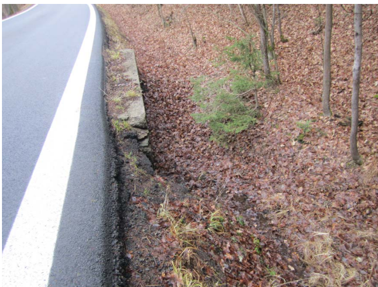
Obrázek 12: Pohled na odvodňovací zařízení
