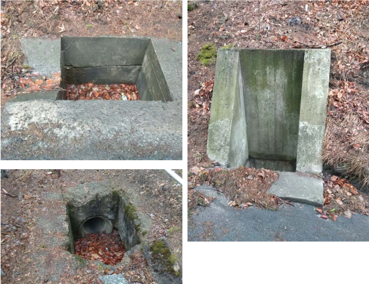
Obrázek 4: Vlevo vpust v km 46,15 a 46,60, vpravo vpust v km 46,29
