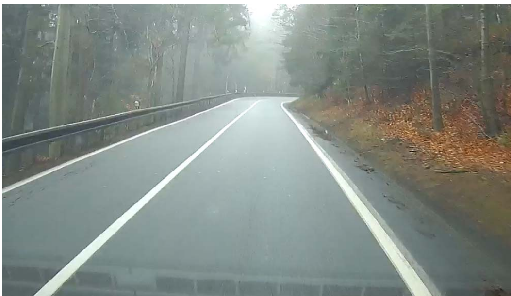
Obrázek 3: Absence směrových sloupků vpravo
