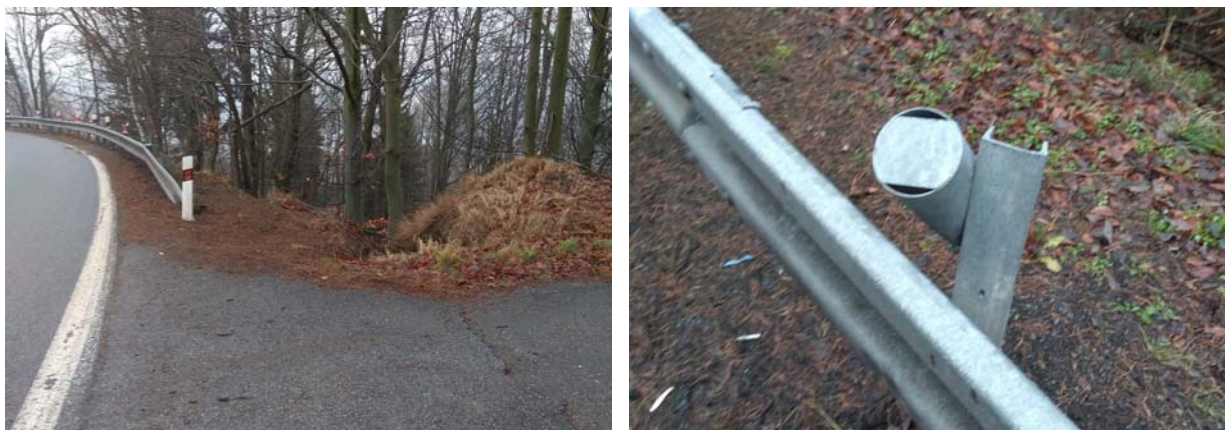
Obrázek 5: Vlevo - svodidlo je příliš krátké, nechrání proti sjetí v celé délce svahu, vpravo – příklad poškození svodidla vpravo v km 46,68
