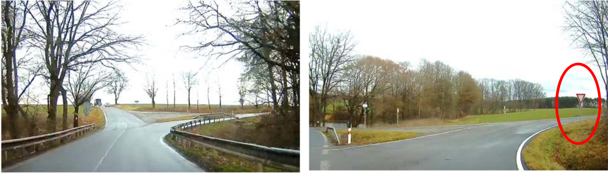
Obrázek 21: Vlevo pohled na křižovatky po směru staničení ze sil. II/122 (hlavní komunikace), vpravo pohled na druhé větvi vedlejšího paprsku
