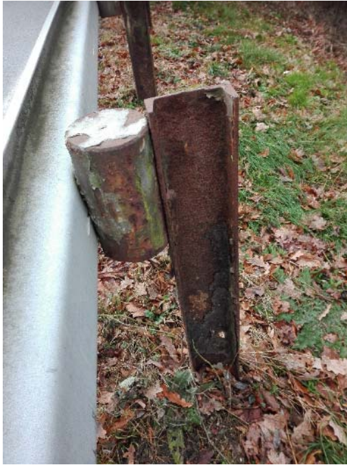
Obrázek 17: Vlevo pohled po směru staničení na nedostatečné délky svodidel (km 31,60), vpravo zbytné svodidlo v km 32,69, dole deficity svodidla.
