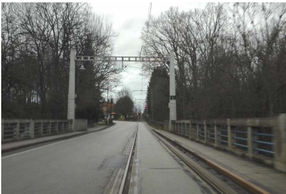
Obrázek 6: Pohled na oblouk za koncem mostu proti směru staničení.
