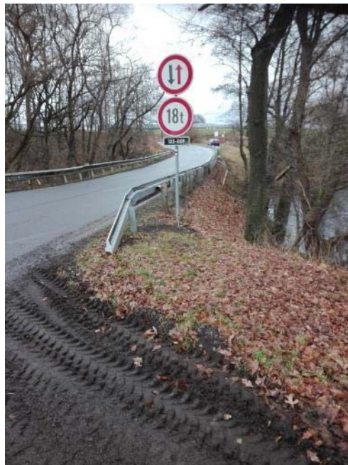
Obrázek 20: DZ – překážka v rozhledu v místě napojení
