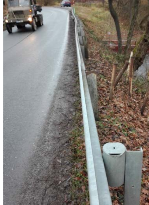
Obrázek 17: Vlevo pohled po směru staničení na nedostatečné délky svodidel (km 31,60), vpravo zbytné svodidlo v km 32,69, dole deficity svodidla.
