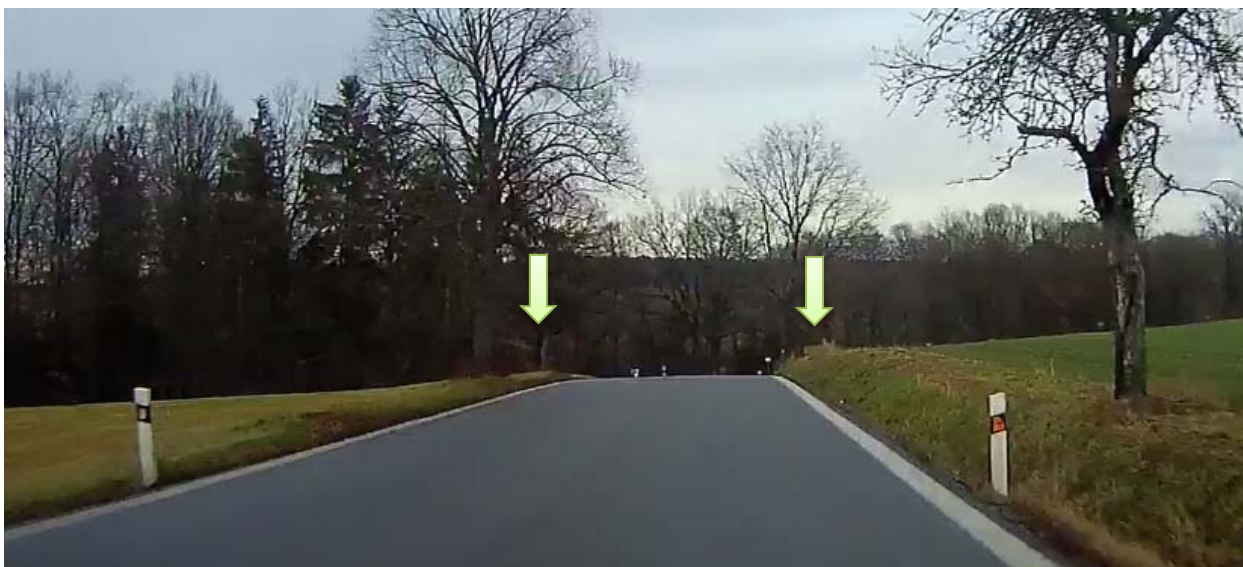
Obrázek 3: Absence střední dělicí čáry a některých směrových sloupků.
