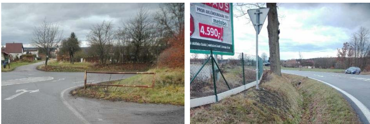
Obrázek 8: Vlevo zbytné zábradlí pod sjezdem (pohled ze sil. II/135), vpravo strom v blízkosti hrany zpevnění.
