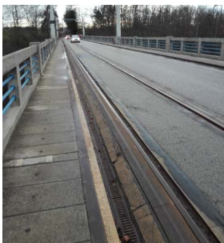
Obrázek 4: Pohled koleje na mostu a přilehlý chodník – kraj vozovky není vhodný k poježdění pro motocyklisty.
