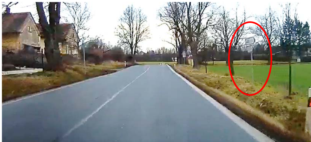
Obrázek 12: Pohled po směru staničení – otočené DZ.
