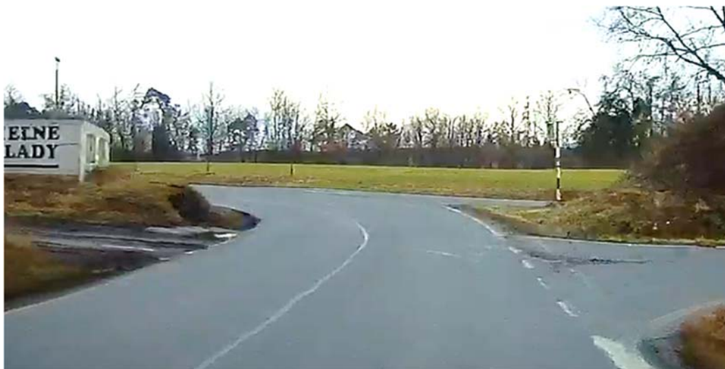
Obrázek 14: Pohled do oblouku po směru staničení.
