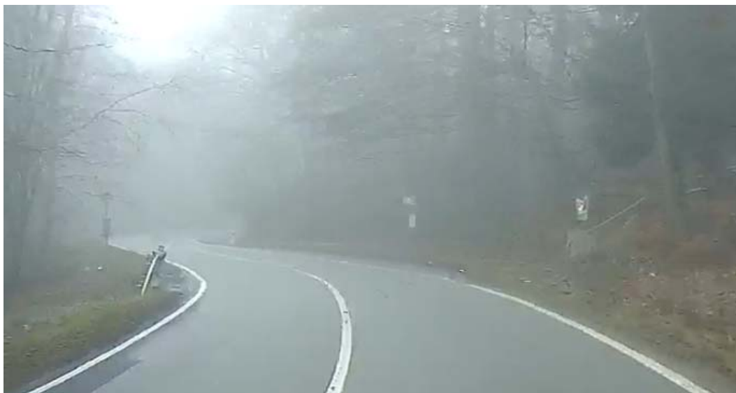
Obrázek 14: Pohled po směru staničení na zastávky.
