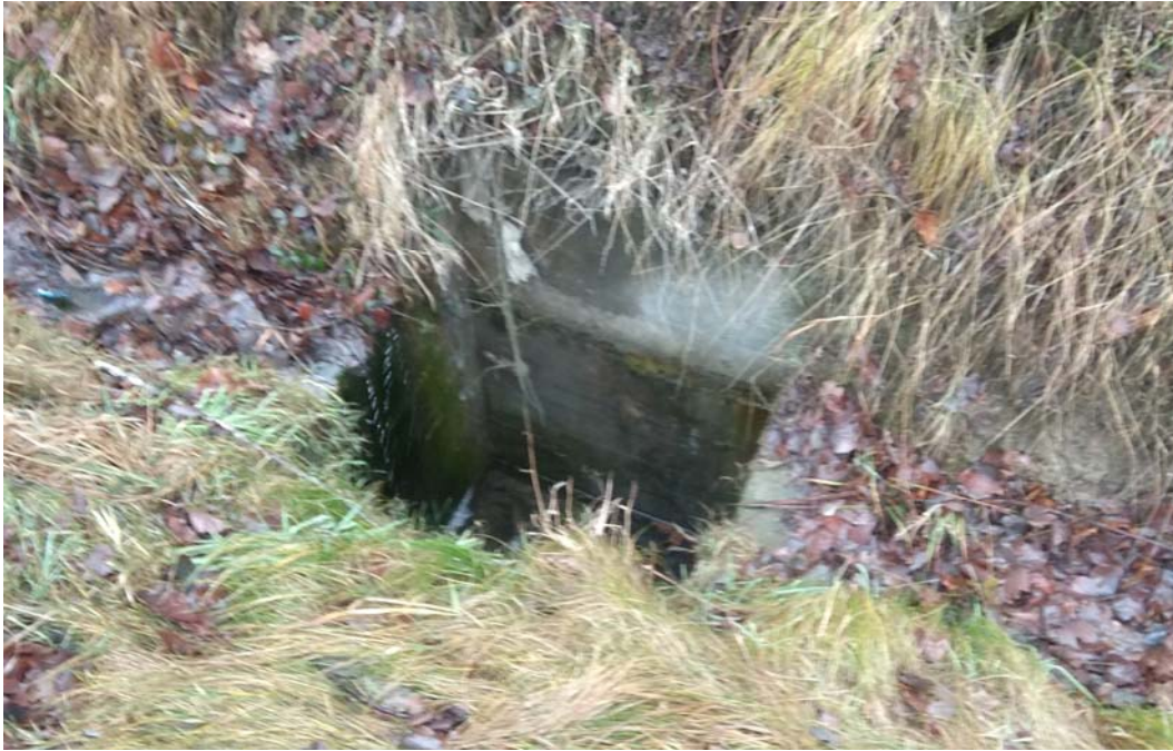
Obrázek 15: Pohled na horskou vpust v pravém příkopu.
