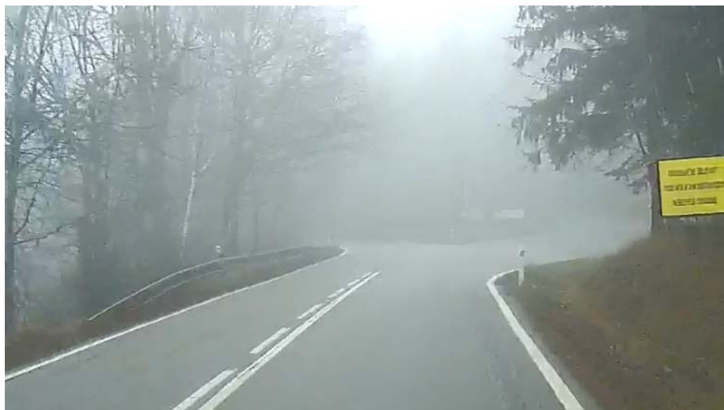
Obrázek 12: Pohled proti směru staničení na sjezd do lomu – absence VDZ
