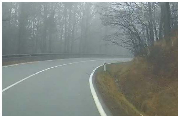
Obrázek 10: Pohled po směru staničení do oblouku v km 0,96 a 2,11, vpravo rozhled pro zastavení omezen přílehlým svahem výkopu.
