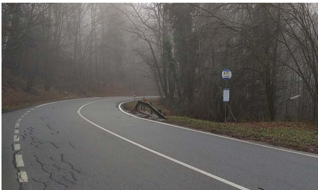
Obrázek 13: Pohled proti směru staničení na svodidlo.
