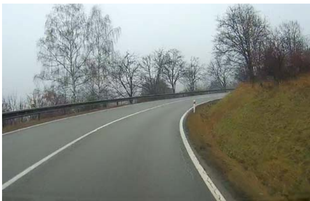
Obrázek 10: Pohled po směru staničení do oblouku v km 0,96 a 2,11, vpravo rozhled pro zastavení omezen přílehlým svahem výkopu.
