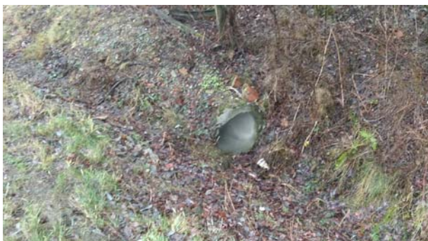
Obrázek 11: Vlevo pohled po směru staničení do pravého příkopu – betonová trouba, vpravo podhled proti směru staničení – balvany v blízkosti PK.
