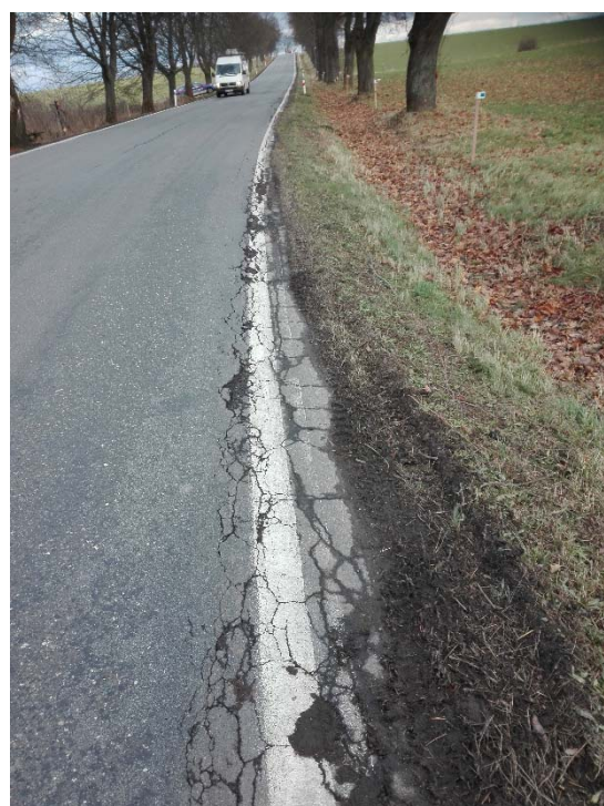
Obrázek 4: Deficity krajnice na úseku.
