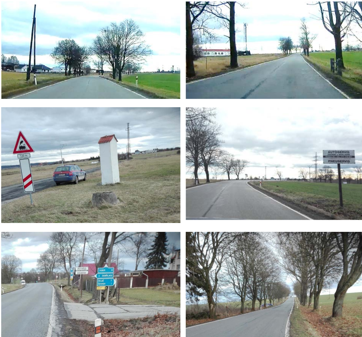
Obrázek 5: Pohled po směru staničení – nahoře km 41,24 sloup vlevo, km 41,39 zábradlí vpravo, uprostřed km 41,65 Boží muka vlevo a km 41,52 reklama vpravo, dole km 42,34 -42,42 – pevné překážky vlevo (pohled proti směru staničení), vpravo dole km 42,43 – 43,31 stromořadí.
