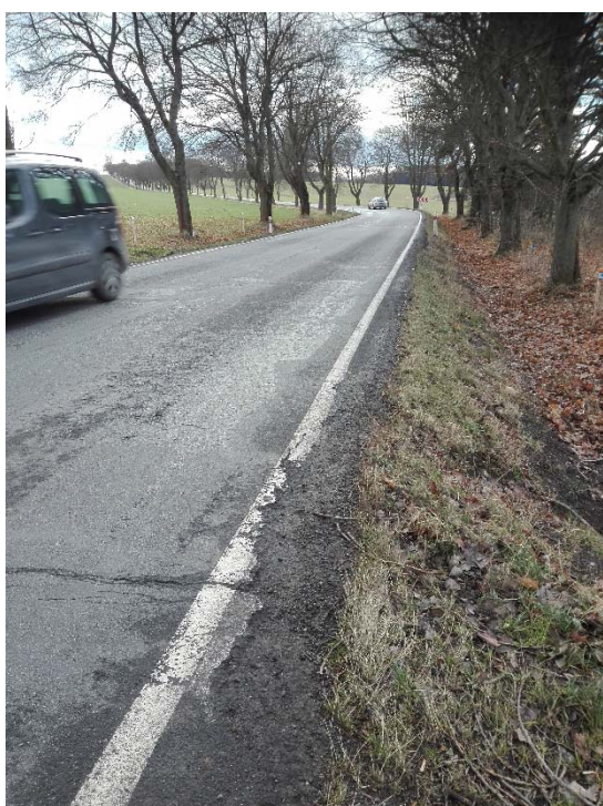
Obrázek 4: Deficity krajnice na úseku.
