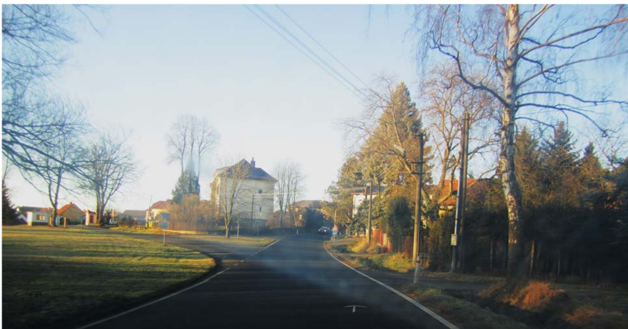
Obrázek 9: Pohled na zástavbu (po směru staničení).
