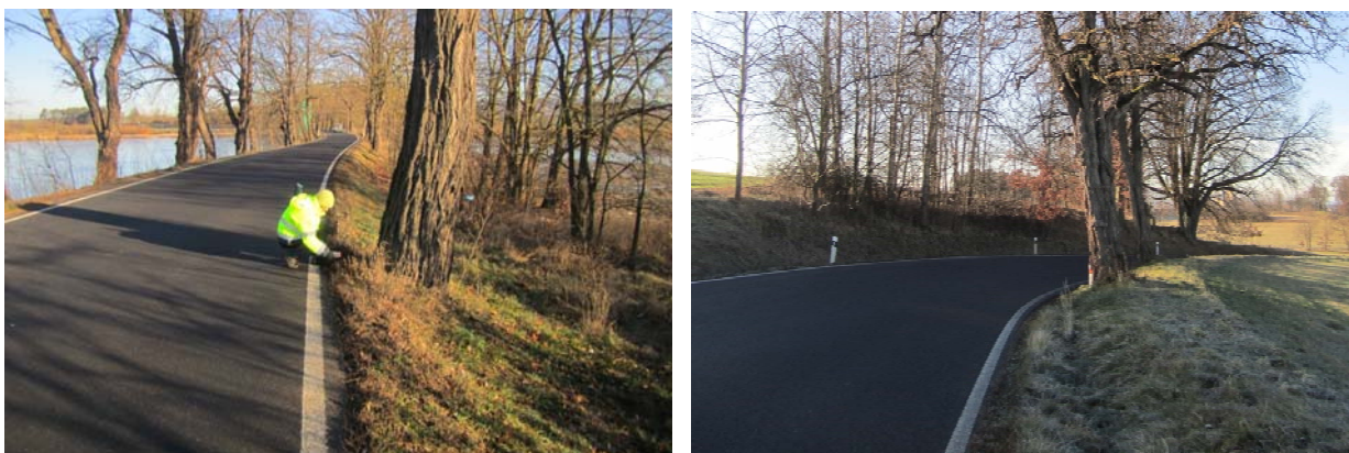
Obrázek 3: Stromy v nebezpečné vzdálenosti (obrázek vlevo 0,56 m od hrany zpevnění na začátku úseku vlevo – obr. proti směru staničení, obrázek vpravo 1,70 m od hrany zpevnění v km 3,57 – obr. po směru staničení).
