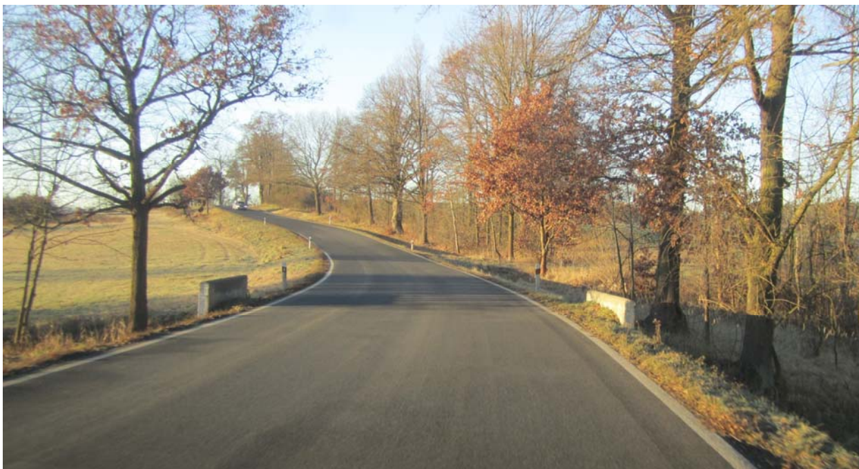
Obrázek 8: Pohled na vystupující čela propustku (po směru staničení).
