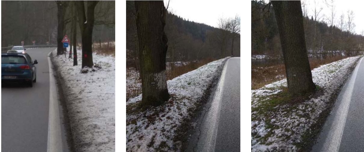
Obrázek 6: Ukázky stromů v těsné blízkosti silnice.
