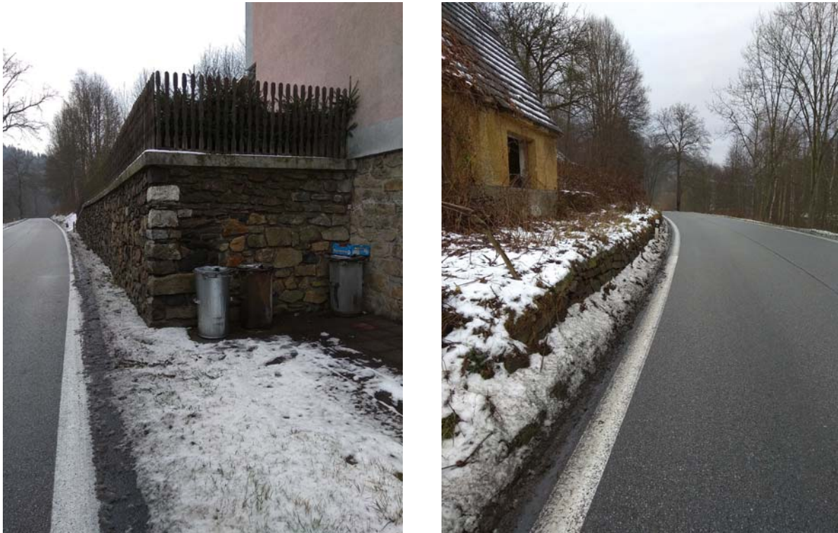
Obrázek 9: Vlevo zárubní zeď v km 3,96 (pohled po směru staničení), vpravo zárubní zeď v km 4,17 (pohled proti směru staničení)
