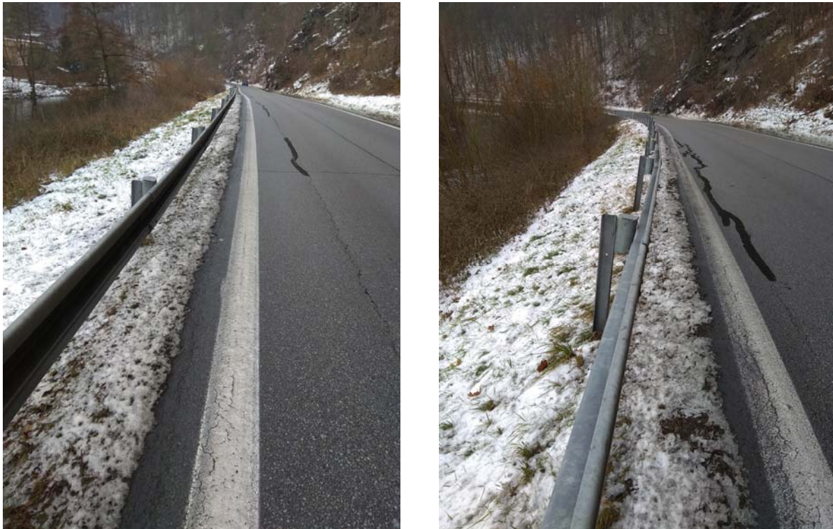
Obrázek 4: Podélné trhliny.
