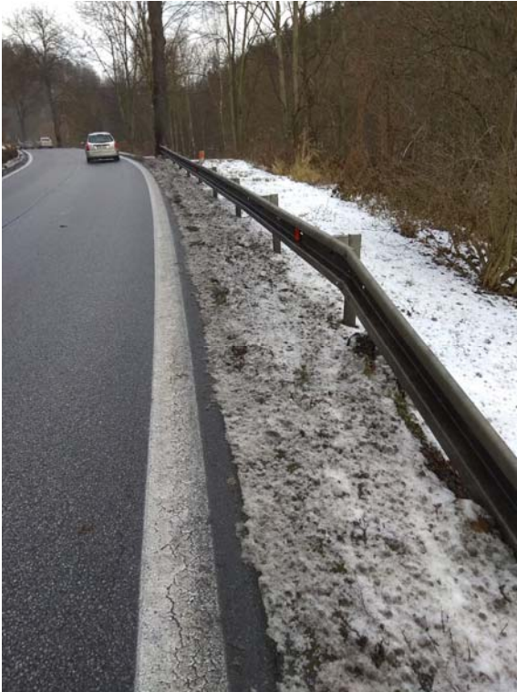
Obrázek 10: Svodidlo a jeho ukončení (pohled proti směru staničení).
