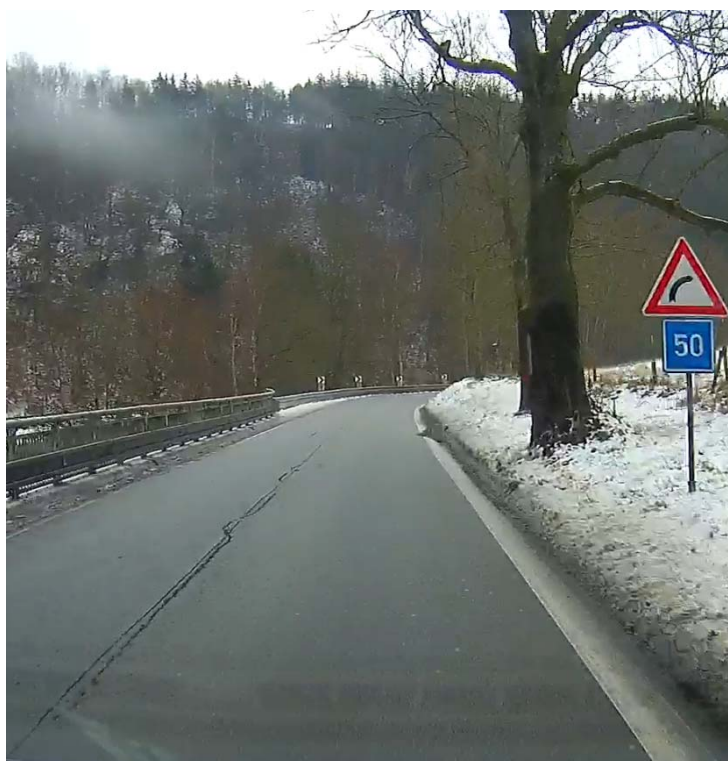
Obrázek 8: Pohled na směrový oblouk ve směru staničení (Č. Krumlov – Větřní).
