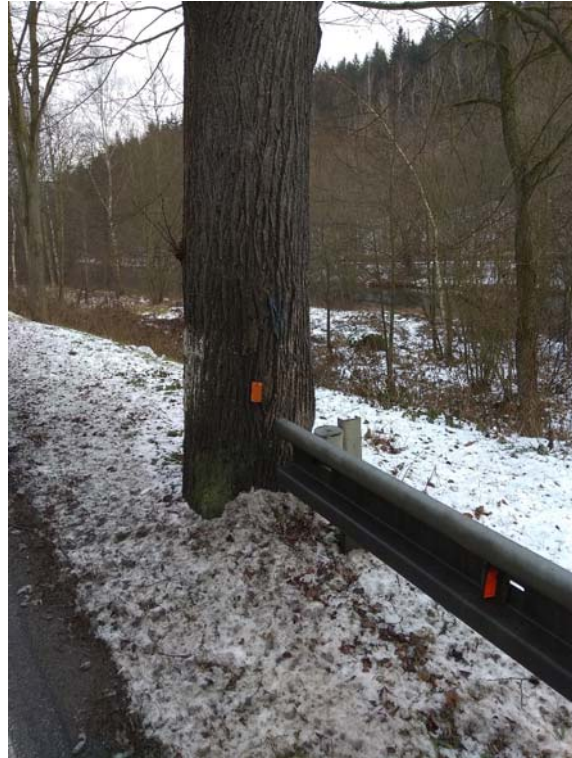
Obrázek 10: Svodidlo a jeho ukončení (pohled proti směru staničení).
