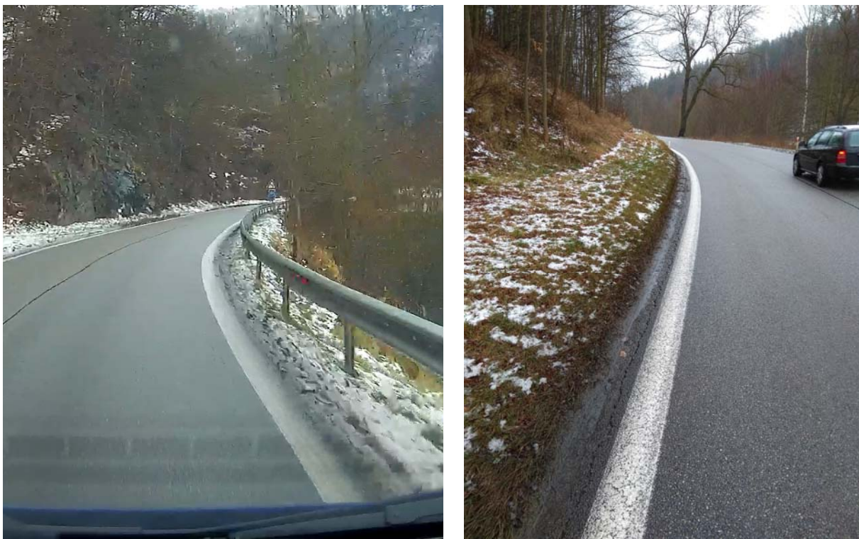
Obrázek 11: příklady chybějící nebo nedostatečně nezpevněné krajnice.
