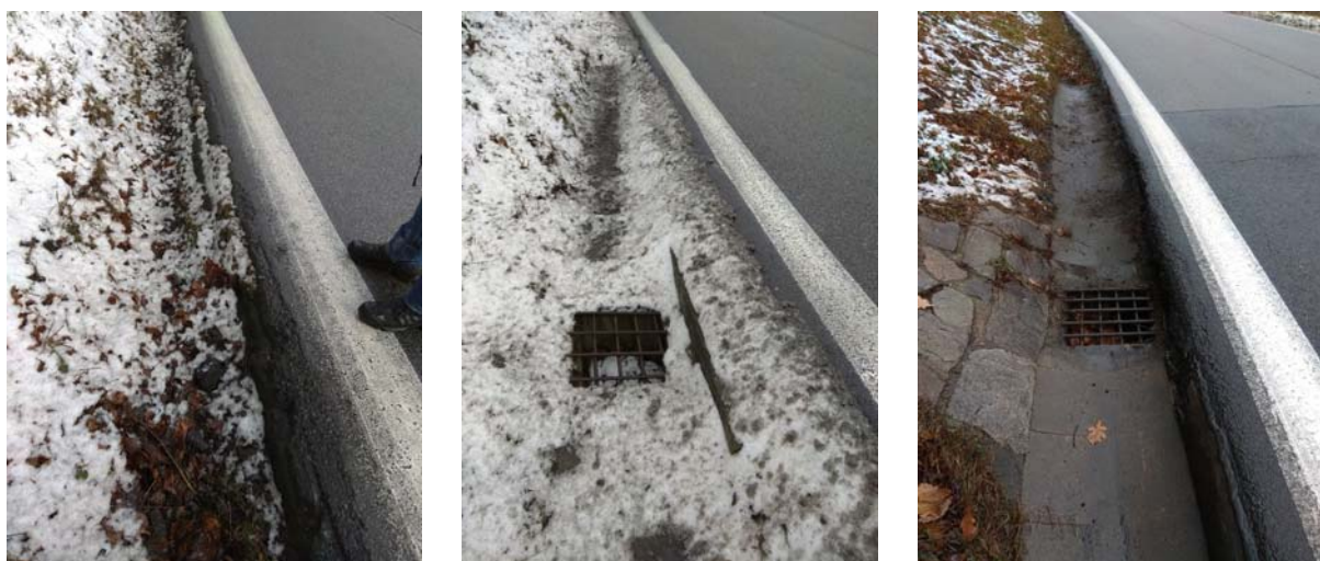
Obrázek 12: Příklady zapuštěného odvodnění.
