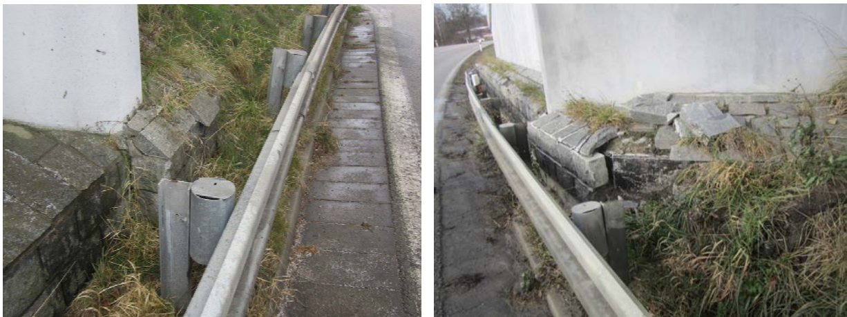
Obrázek 7: Pohled proti směru staničení do oblouku.
