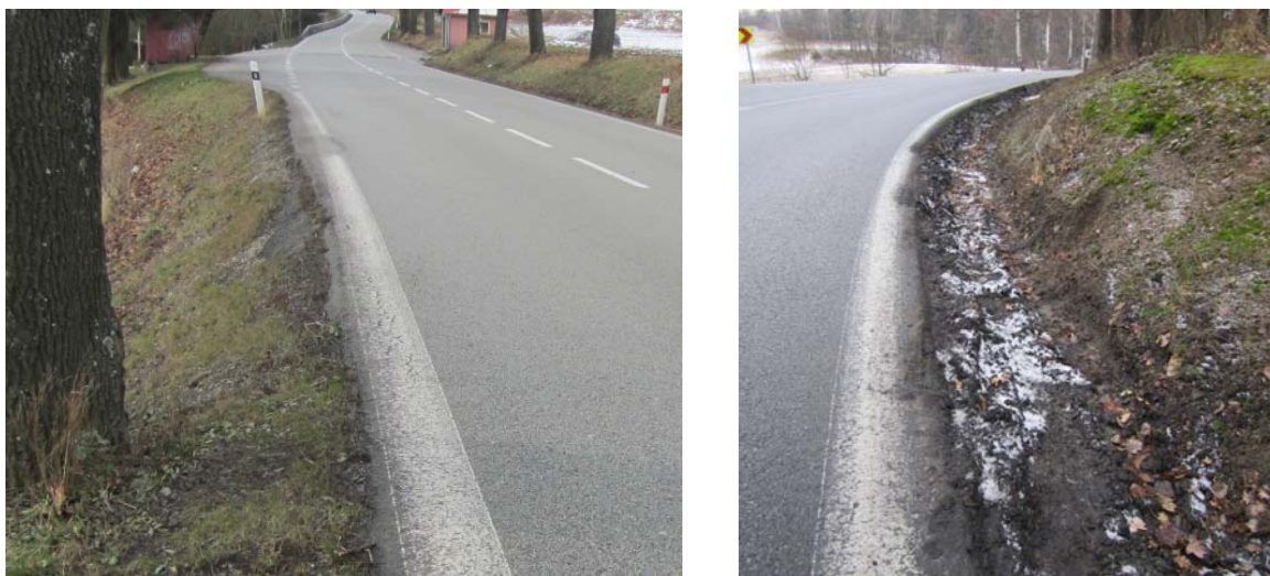
Obrázek 3: Příklad nedostatečné krajnice.
