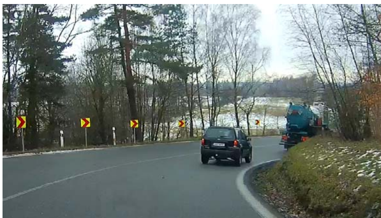
Obrázek 9: Pohled do směrového oblouku proti směru staničení.
