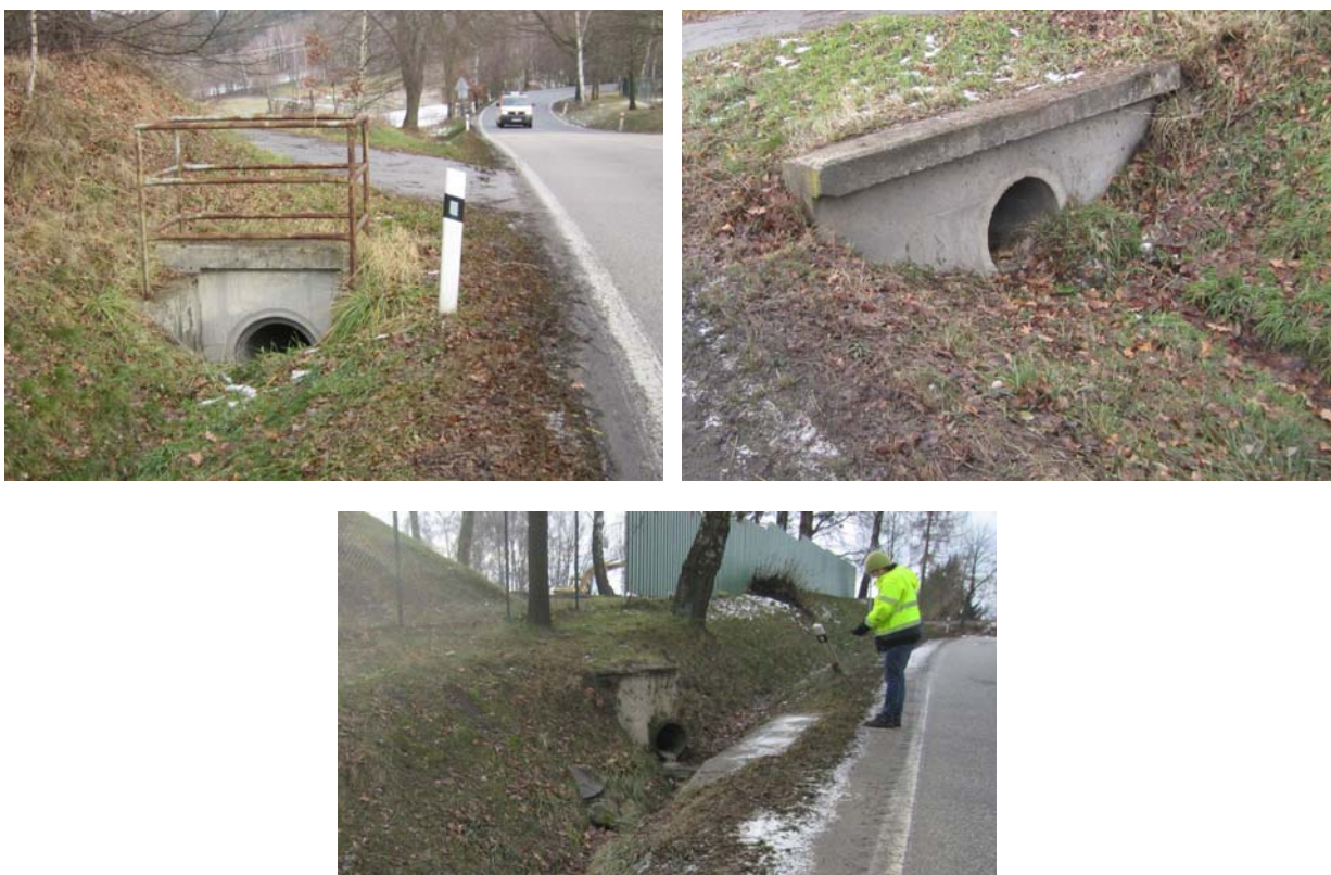
Obrázek 8: Nahoře pohled na čela propustku, dole pohled na vyústění kanalizace do pravého příkopu (pohled proti směru staničení).
