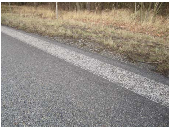
Obrázek 5: Příklady nevýrazného VDZ a místa s chybějícími sloupky na sledovaném úseku.
