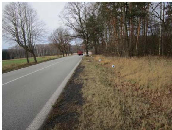
Obrázek 5: Příklady nevýrazného VDZ a místa s chybějícími sloupky na sledovaném úseku.
