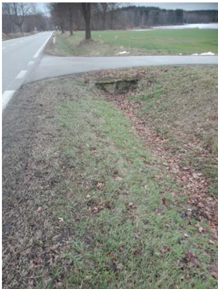
Obrázek 7: Nefunkční odvodnění.
