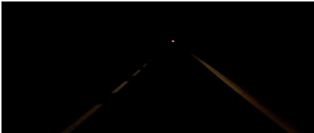
Obrázek 4: Pohled na PK v nočních hodinách – směrové sloupky nejsou vidět.
