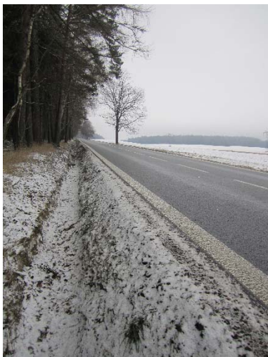
Obrázek 8: Pohled proti směru staničení na provedení odvodnění.
