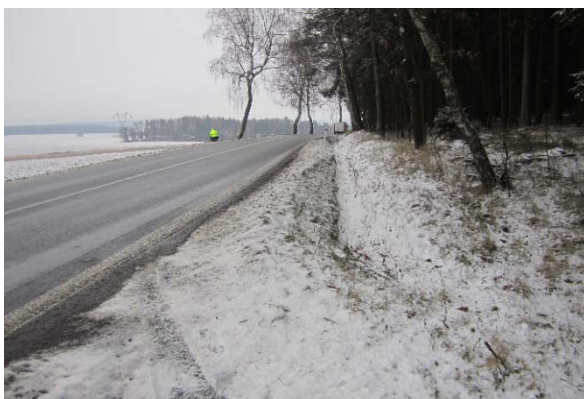
Obrázek 9: Nedostatečný rozhled na výjezdech z lesních cest.
