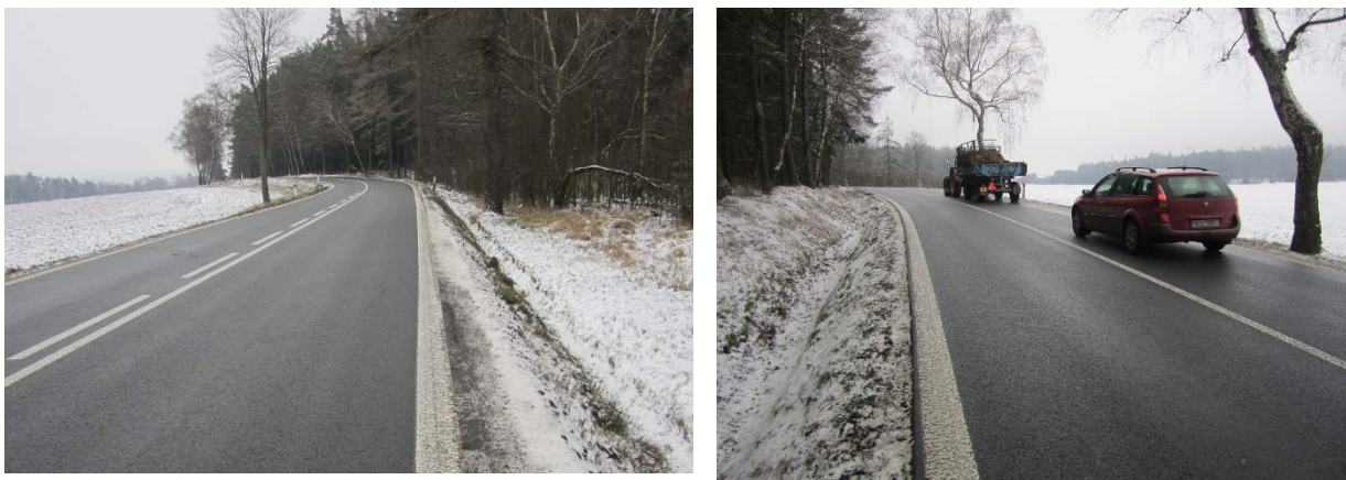
Obrázek 6: Vlevo pohled do oblouku po směru staničení (ve směru většiny DN) a vpravo pohled z protisměru .
