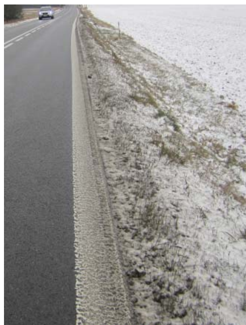
Obrázek 3: Pohled ve směru staničení na levou krajnici před obcí Lipolec.
